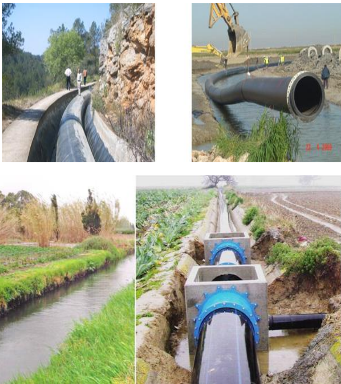
Figura N° 4. Canalización de agua para riego por tuberías Fuente: Elaboración Propia.
