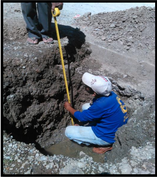
Ilustración 27 Calicata N°5 – Línea de Conducción
