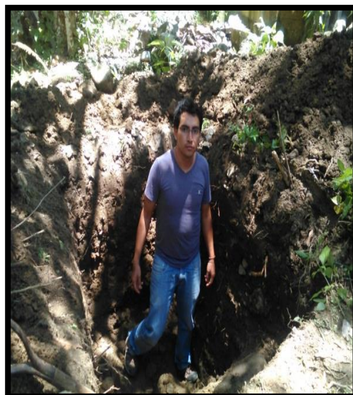
Ilustración 24 Calicata N°2 – Desarenador.
