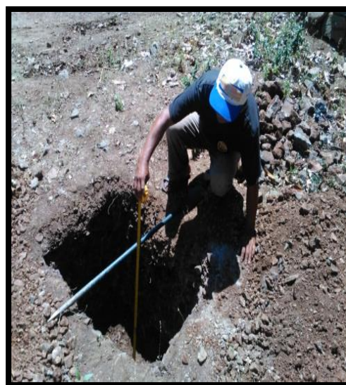
Ilustración 26 Calicata N°4 – Línea de Conducción
