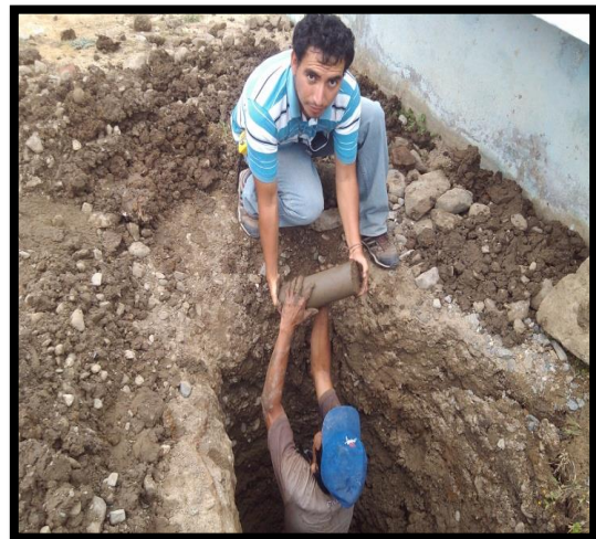
Ilustración 34 Calicata N°12– Planta de Tratamiento
