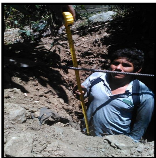
Ilustración 25 Calicata N°3 – Desarenador.
