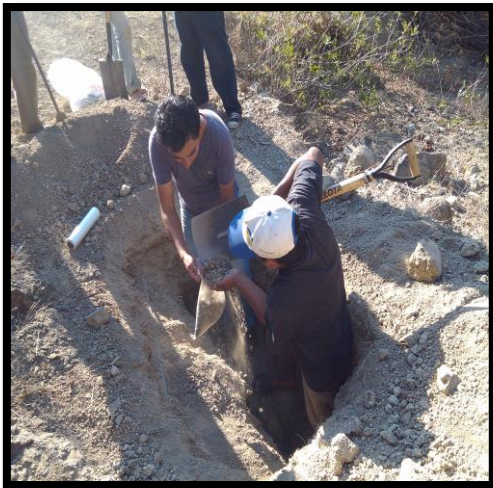
Ilustración 33 Calicata N°11– Línea de Conducción
