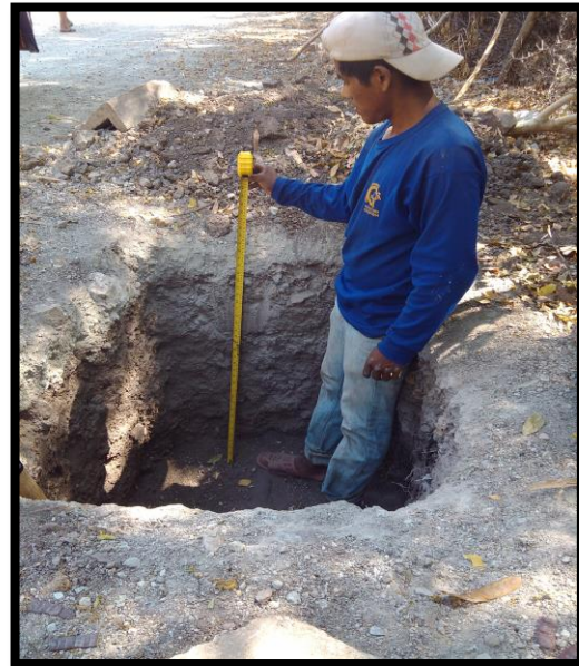
Ilustración 30 Calicata N°8 – Línea de Conducción
