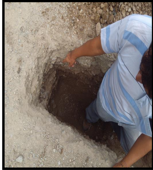
Ilustración 28 Calicata N°6 – Línea de Conducción
