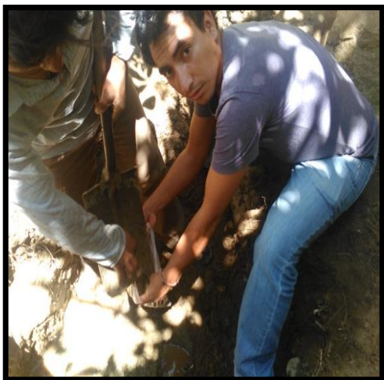
Ilustración 23 Calicata N° 1 – Captación.
