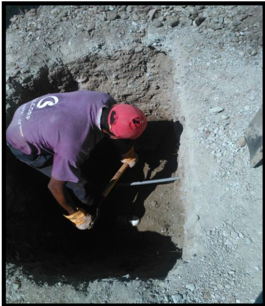
Ilustración 29 Calicata N°7 – Línea de Conducción
