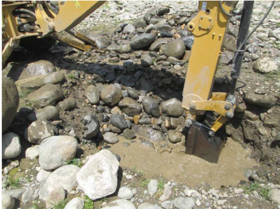
FOTO 3.5: Calicata C-02. Uso de maquinaria pesada debido al estrato que existe. Margen derecho del Río Chochope.
