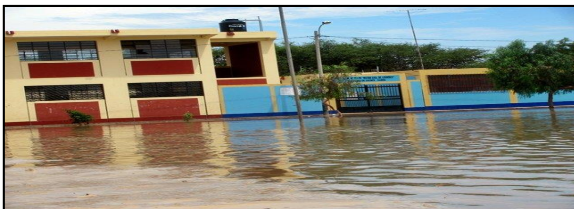
Fig. 7: Daños Ocasionados a los locales escolares por el fenómeno del niño
