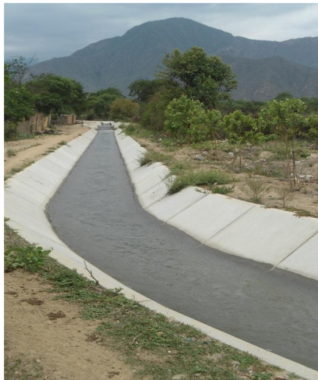
Foto N° 20 Canal de irrigación – Sector “El Arrozal”
