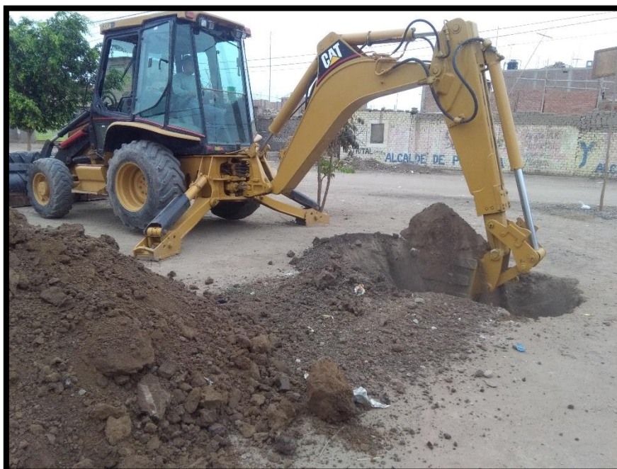
FIGURA 29: USO DE LA RETROEXCAVADORA EN LA EXCAVACIÓN DE LA CALICATA PARA ALCANZAR LA PROFUNDIDAD DE EXPLORACIÓN
