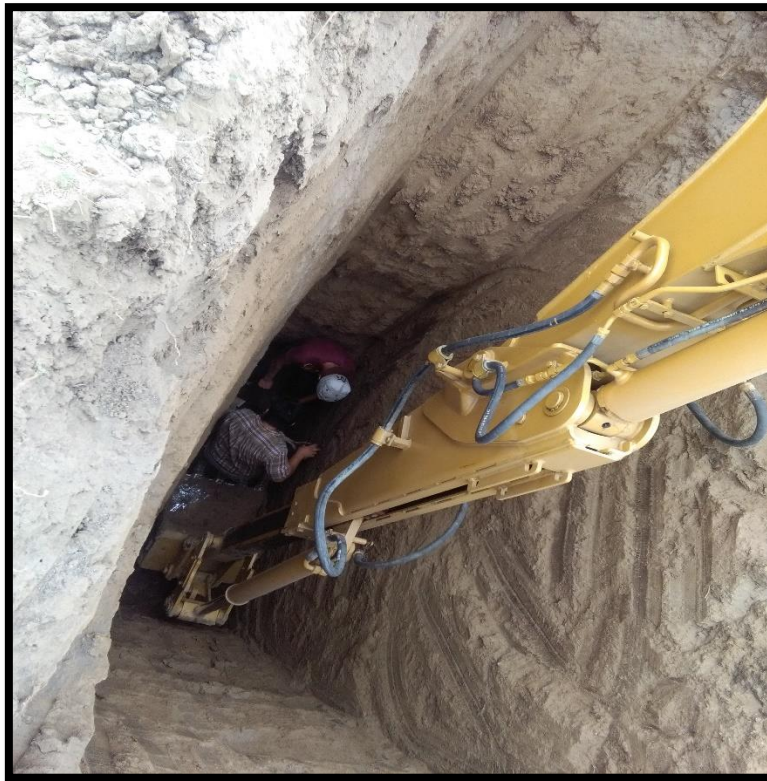
FIGURA 30: MUESTREO EN UNA DE LA CALICATAS EXCAVADAS
