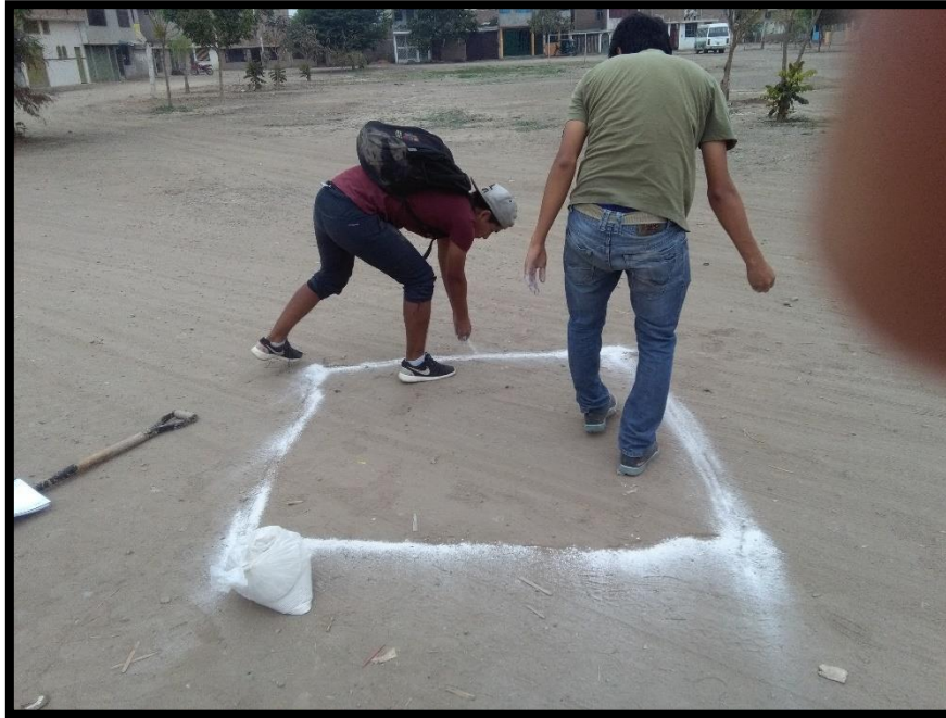
FIGURA 28: DELIMITACIÓN DE LA CALICATA A EXCAVAR
