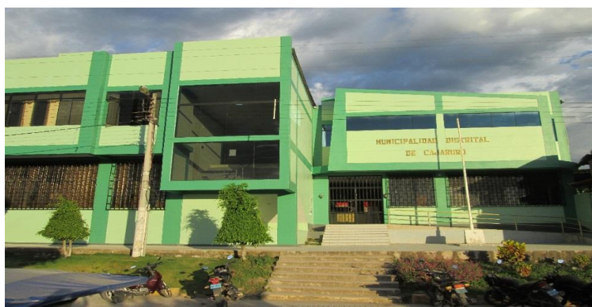
Figura N° 09 Municipalidad Distrital de Cajaruro
