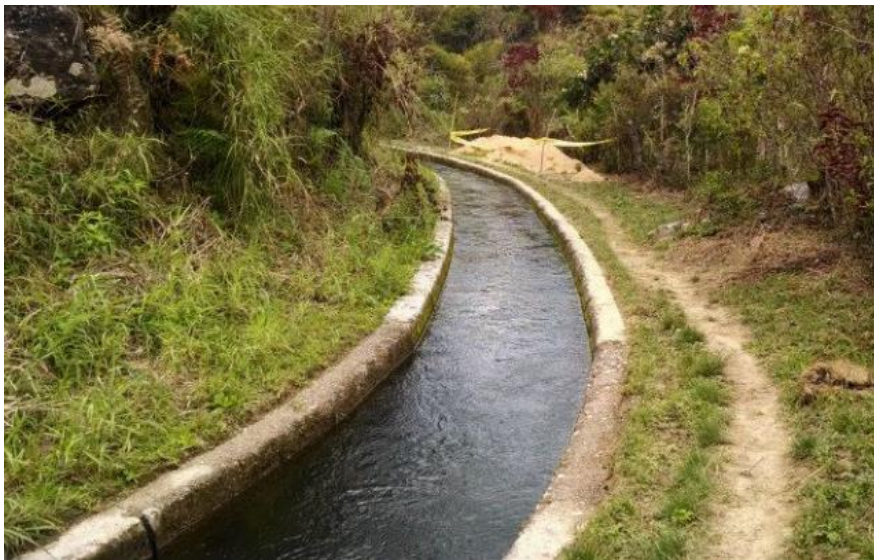
Figura 2 Canal de conducción
