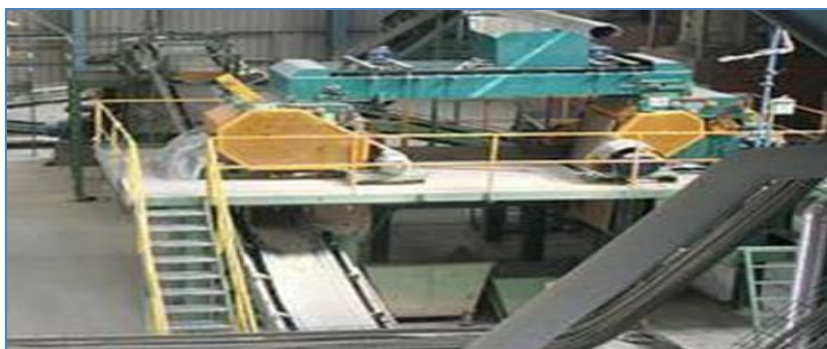
FIGURA N° 13: Tolva de almacenamiento
