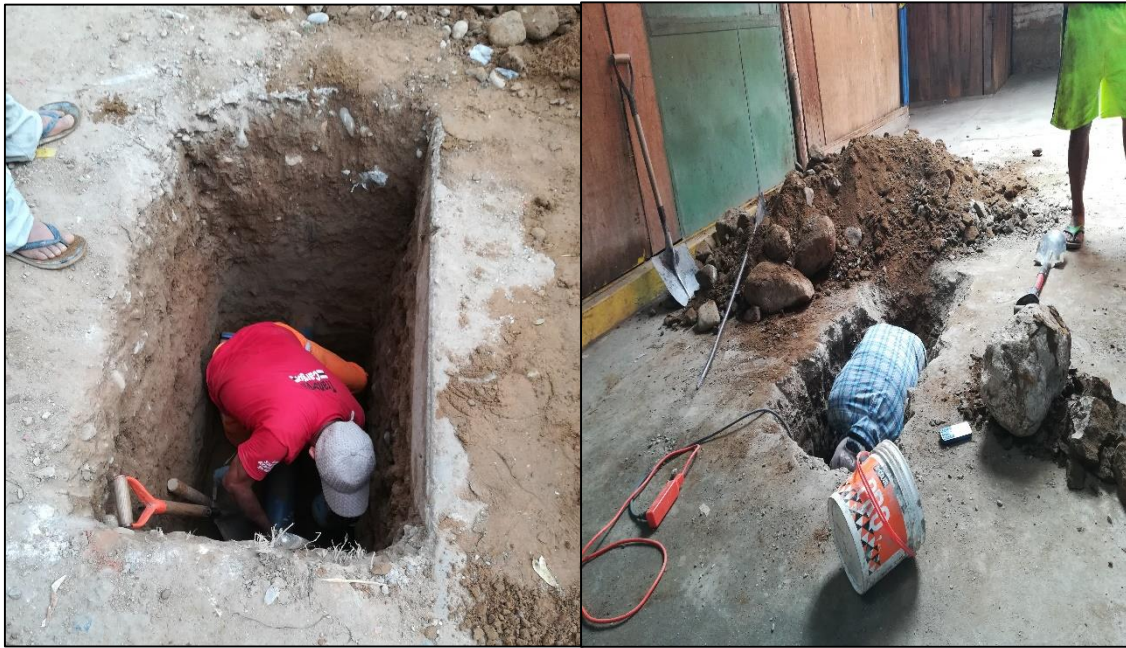
Foto N° 04 : Excavaciones de calicatas
