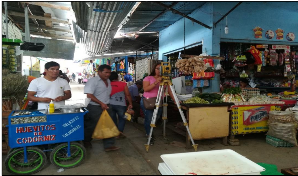
Foto N° 01 : Nivelando estación total
