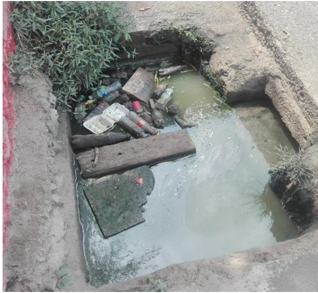
Figura N° 7: Pozo de Sedimentado en el área de lavado de Servicentro San Miguel
