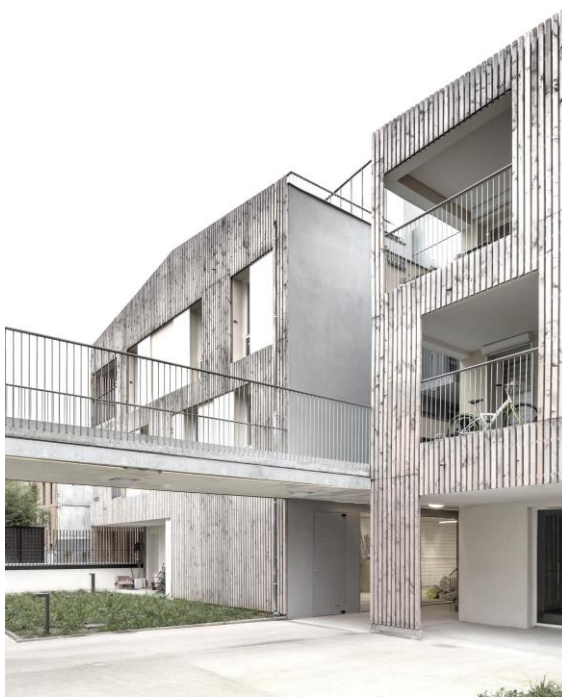
Ilustración 5. Co-Vivienda Nanterre, Francia
