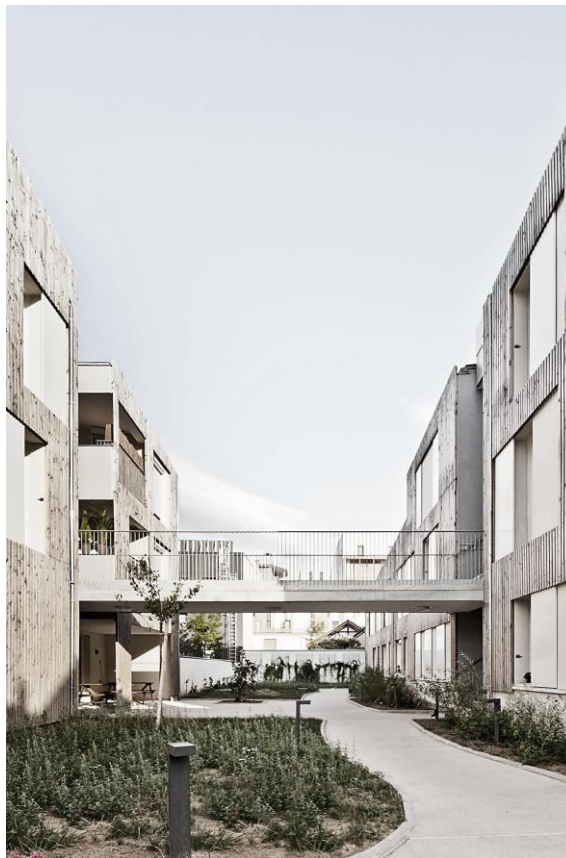
Ilustración 6. Co-Vivienda Nanterre, Francia.
