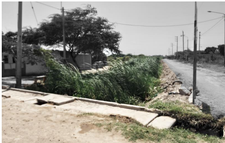
Ilustración 31. Dren 500 con vegetación aglomerada que impide el fluido de las aguas residuales. Fuente: Elaboración propia.
