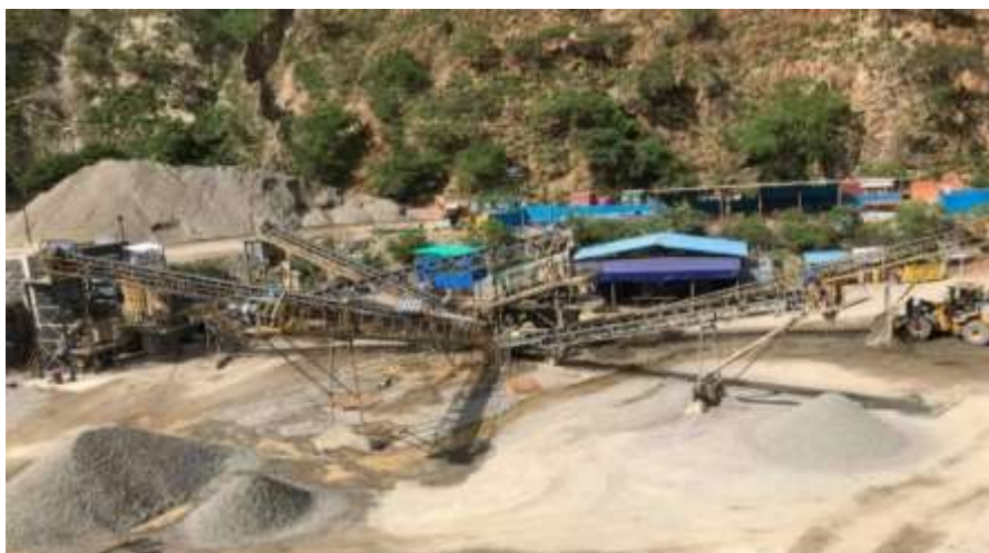
Figura 10. Planta Chancadora de la Empresa Astaldi - Piura.
