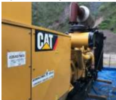
Figura 22. Grupo electrógeno.
