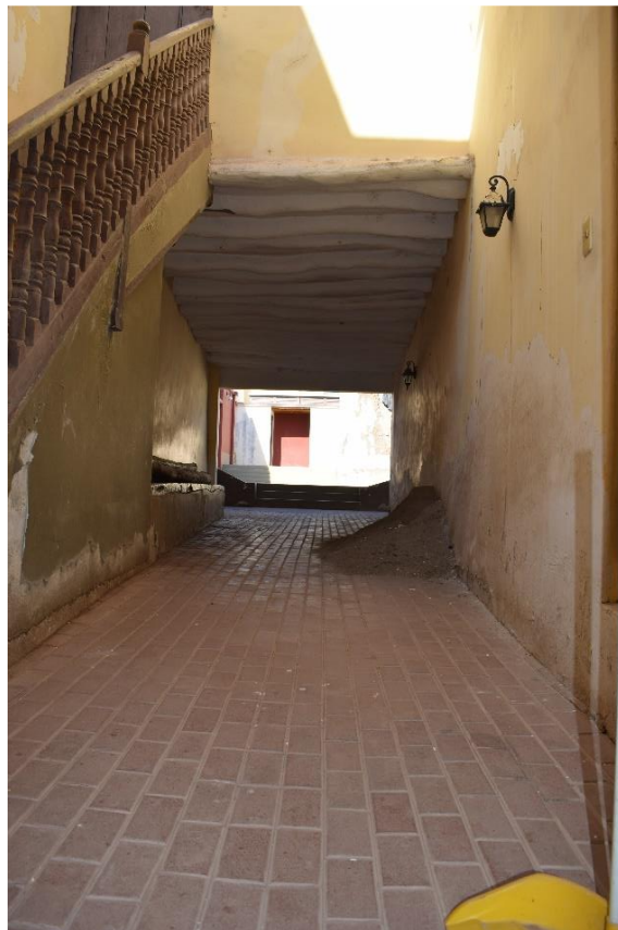
Imagen 52. Ambiente 109. Chiflón, antigua caballeriza. Fotografía interior de la Casona Montjoy. Fuente Propia
