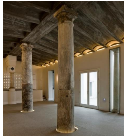
Imagen 23. Columnas rescatadas del antiguo matadero como parte de la intervención en Cádiz. España
