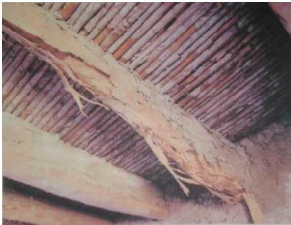
Imagen 21. Vigas de Eucalipto y entrepiso de Caña Brava. Fotografía Arq. Jorge Cosmópolis
