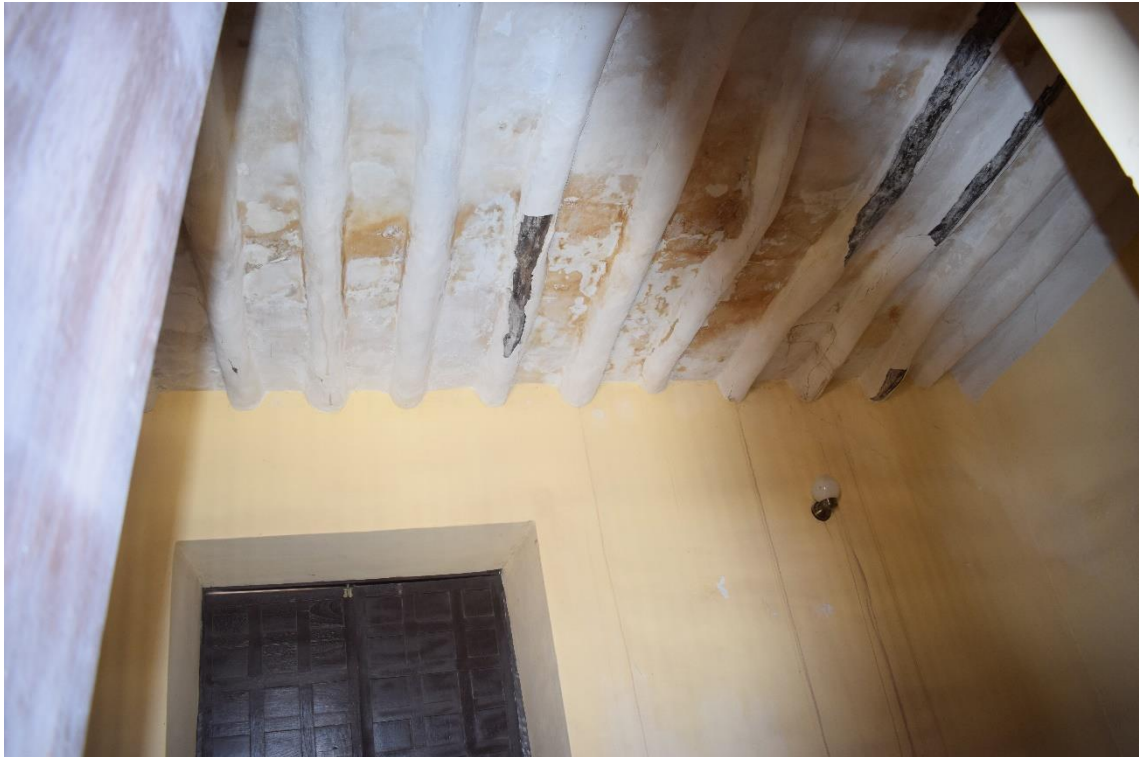
Imagen 51. Ambiente 201. Salón sin accesibilidad. Fotografía interior de la Casona Montjoy. Fuente Propia
