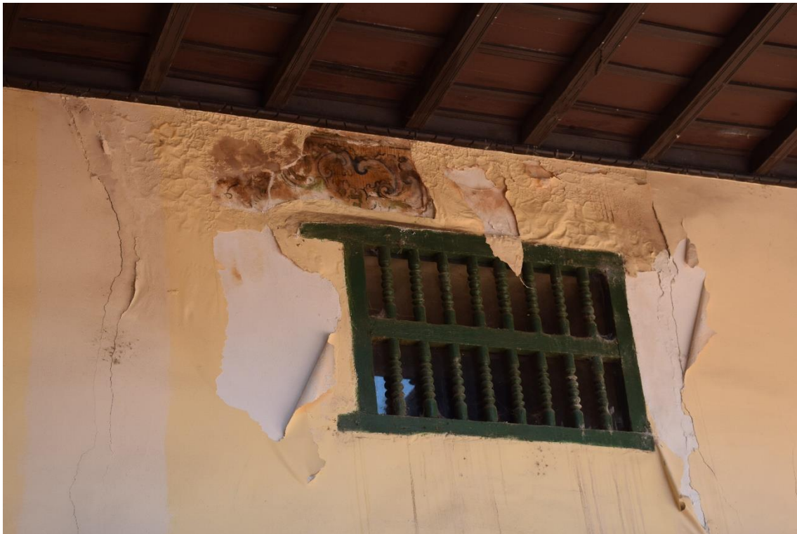
Imagen 46. Ambiente 104. Pintura del muro interior de la galería perteneciente al Patio principal. Fotografía interior de la Casona Montjoy. Fuente Propia
