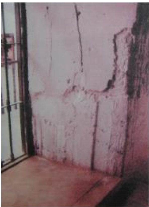
Imagen 19. Restauración de calzaduras al interior de la Casona Montjoy. Fotografía Arq. Jorge Cosmópolis
