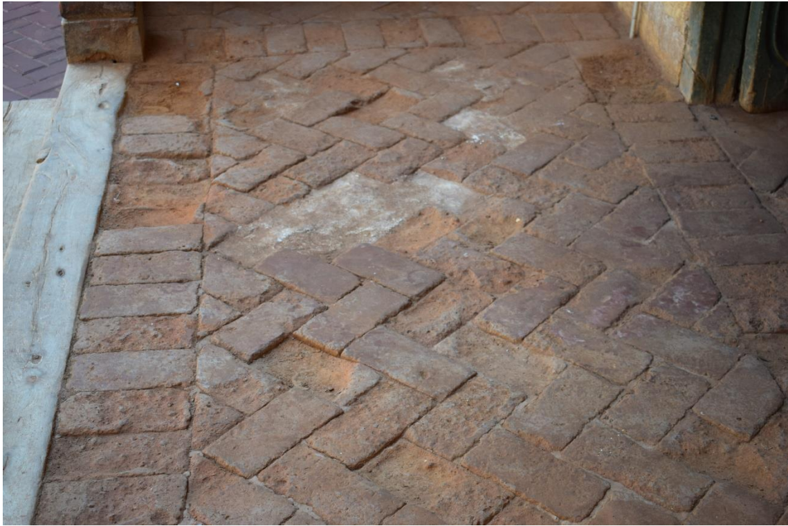
Imagen 48. Ambiente 104. Galería, ingreso a Salón principal. Fotografía interior de la Casona Montjoy. Fuente Propia
