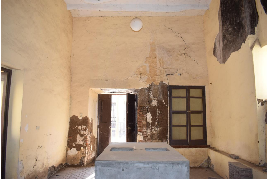
Imagen 45. Ambiente 117. Cocina. Fotografía interior de la Casona Montjoy. Fuente Propia
