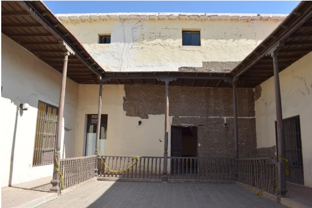
Imagen 12. Segundo patio interior de la Casona Montjoy. Lambayeque 2018. Fotografía Propia
