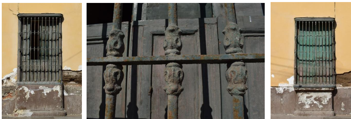
Imagen 67. Detalle Carpintería Metálica en ventanales exteriores. Fuente Propia
