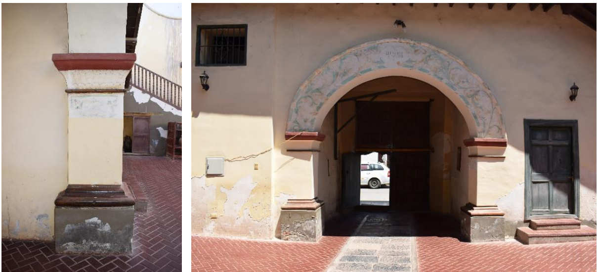
Imagen 75. Arco de medio punto pasando el Zaguán. Lambayeque 2018. Fuente Propia
