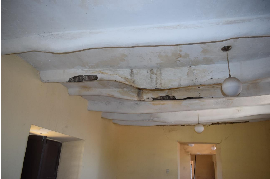
Imagen 53. Ambiente 206. Salón sin accesibilidad. Fotografía interior de la Casona Montjoy. Fuente Propia
