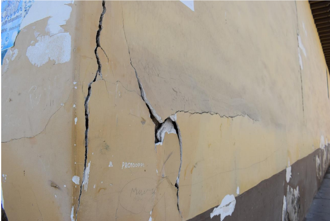
Imagen 44. Fachada Sur. Calle San Martin. Fotografía exterior de la Casona Montjoy. Fuente Propia
