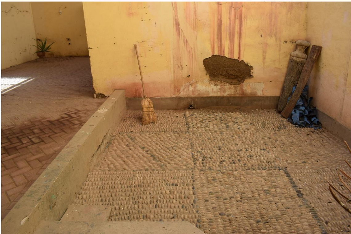
Imagen 49. Ambiente 118. Piso original de piedra de río, 1754 (derecha). Piso de ladrillo pastelero, 2009 (izquierda). Fotografía interior de la Casona Montjoy. Fuente Propia
