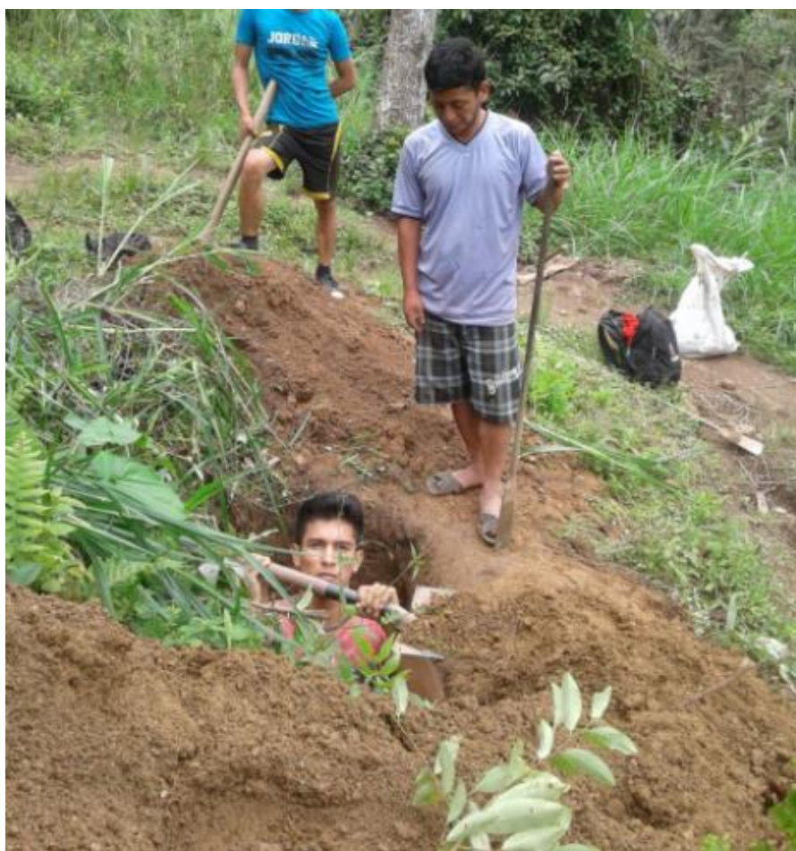
Fotografía N°. 10: Excavación de calicatas para extraer muestras de suelos.
