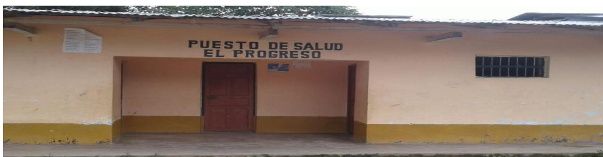
Fotografía N°. 17: Puesto de salud el Progreso.
