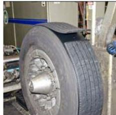
**Aplicación de cemento a los extremos de la banda de rodamiento**
