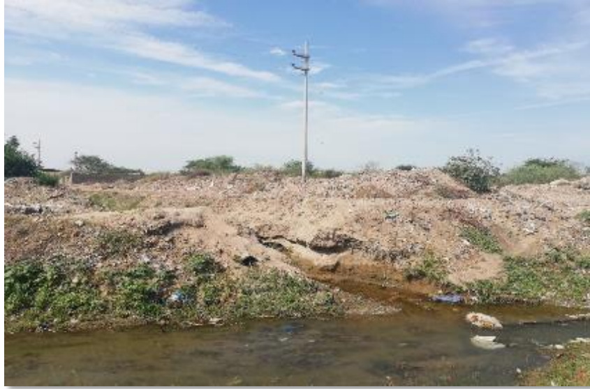
Figura 30. Residuos sólidos en el agua
