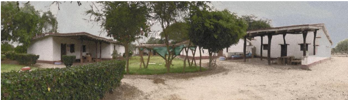
Ilustración 49. Estado de conservación de la Aldea Cúsupe. Fuente: Propia.
