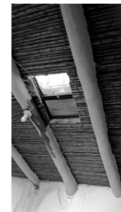
1. Collarín 2. Torta de barro 3. Caña brava 4. Viga empotrada 5. Revoco de cal trabajado 6. Mortero 7. Muro de adobe
