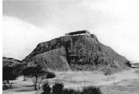
Figura 01: Siglo X. Pirámides de Túcuma, primeras construcciones habitables en el territorio lambayecano formadas por doce pirámides y construido en su totalidad de adobe.
