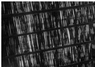
Figura 03. 2019. Fotografía de estructura interna de quincha.
