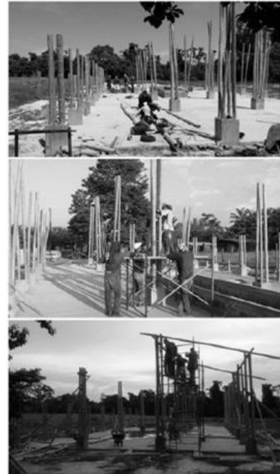
Ilustración 40: Vista armado de estructura en Guadua taller de Bio-construcción en la vereda J10 del municipio de Tibu, región del Catatumbo, Norte de Santander, Colombia. Fuente: HURTADO FIGUEROA, Oswaldo; VALERA ZAPATA, José Luis.
