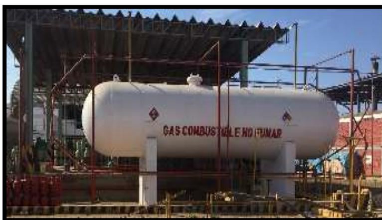
**Figura 30. Sistema de tuberías con aspersores para el control, reducción y apagado de inesperados escenarios de fuego o explosiones del tanque estacionario**
