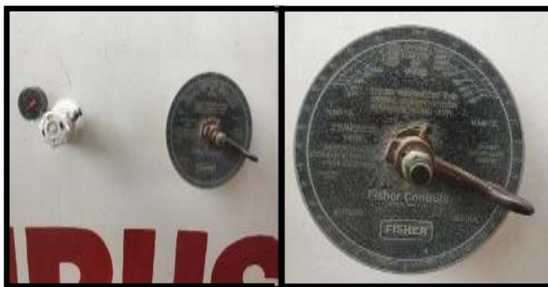
**Figura 34. Manómetro rotatorio para la medición en porcentaje de volumen del GLP almacenado en el tanque estacionario y en los dos camiones cisternas**
