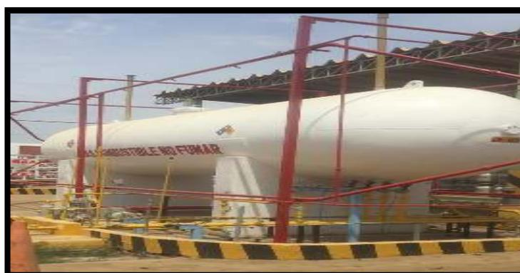
**Figura 29. Sistema de tuberías de la línea de descarga del líquido y del vapor de GLP desde el camión cisterna al tanque estacionario**
