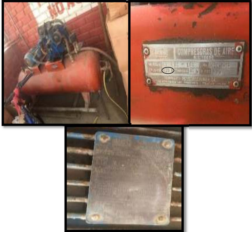
**Figura 76. Compresora marca “Romer” de 5 HP que abastece el sistema neumático de la empresa**
