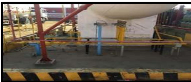
**Figura 32. Válvulas de cierre de emergencia**
