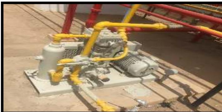
**Figura 23. Compresora de las presiones del líquido y vapor del GLP en el momento del trasiego desde el camión cisterna al tanque estacionario**
