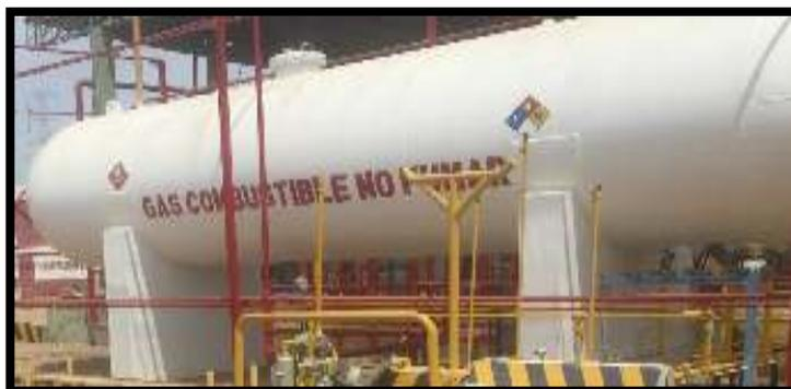
**Figura 28. Tanque estacionario con capacidad de almacenamiento para 12 000 galones de GLP**
