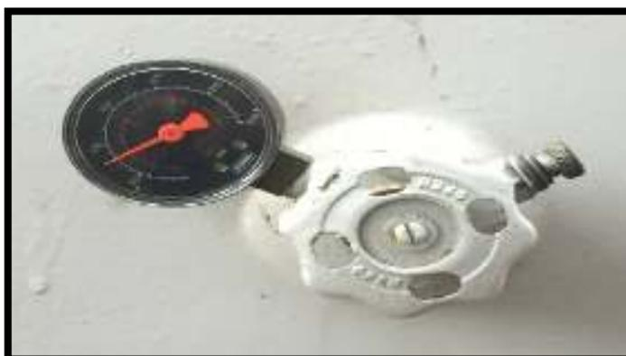
**Figura 35. Medidor de presión del GLP en el tanque estacionario y en los dos camiones cisternas**
