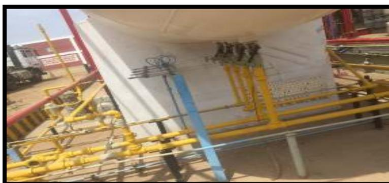
**Figura 31. Línea de succión del líquido de GLP**
