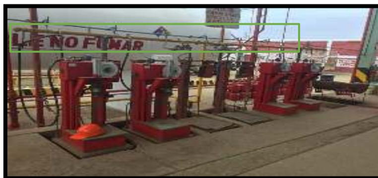
**Figura 33. Sistema manifold de tuberías de 2 pulgadas de cédula 40 que abastece a seis balanzas envasadoras de GLP**
