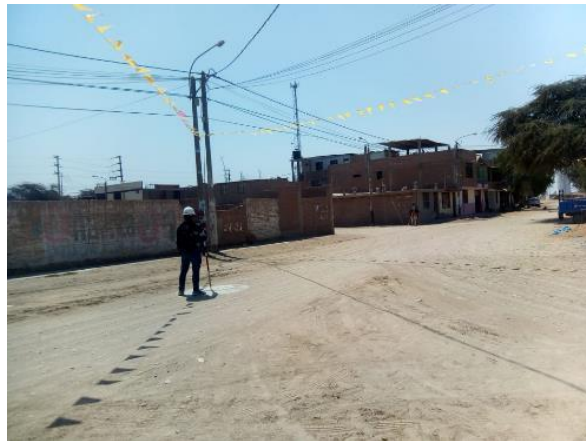
Fotografía 26: Levantamiento topográfico en la calle Santa Ana
