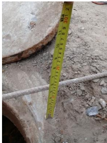
Fotografía 46: Realizando le medición de altura de buzón (cota de tapa)
