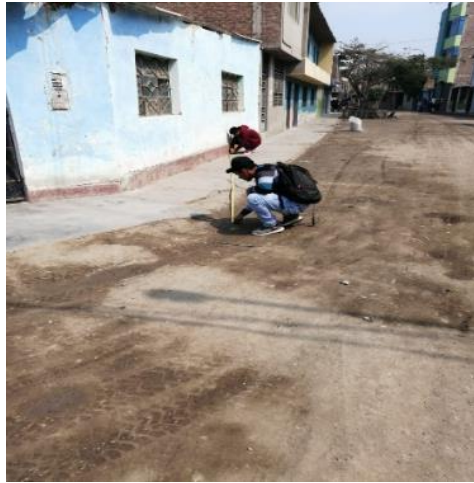
Fotografía 39: Realizando esquinera de agua en la calle Elías Aguirre
