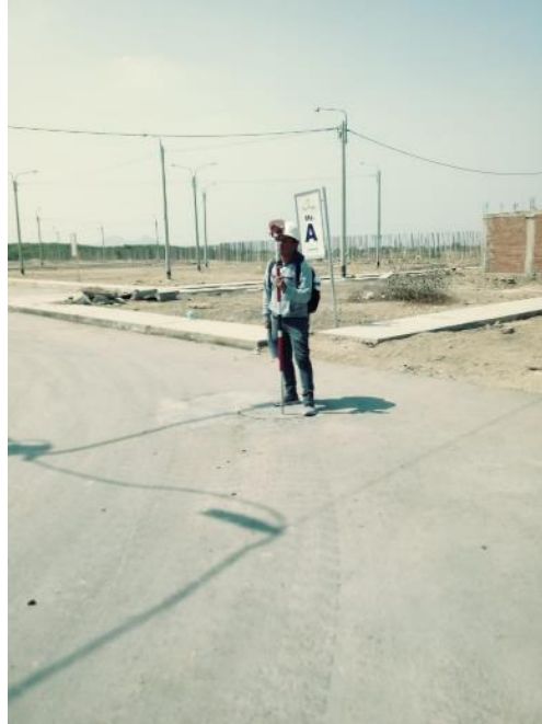
Fotografía 23: Levantamiento topográfico, en la zona de la calle El Carmen
