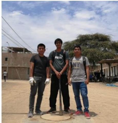
Fotografía 45: Realizando la inspección de buzones
