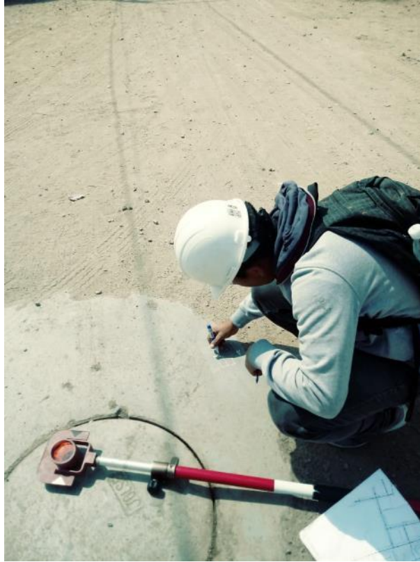
Fotografía 19: Levantamiento topográfico, puntos referenciales en buzones
