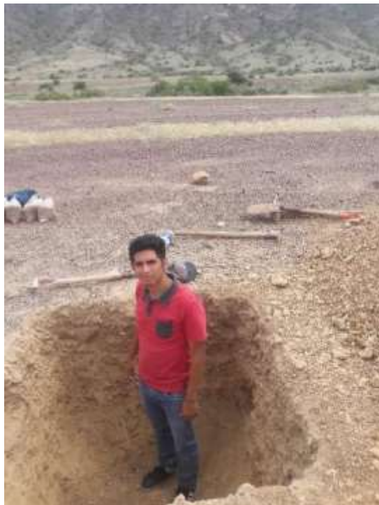
Fotografía N°2: Excavación de calicatas
