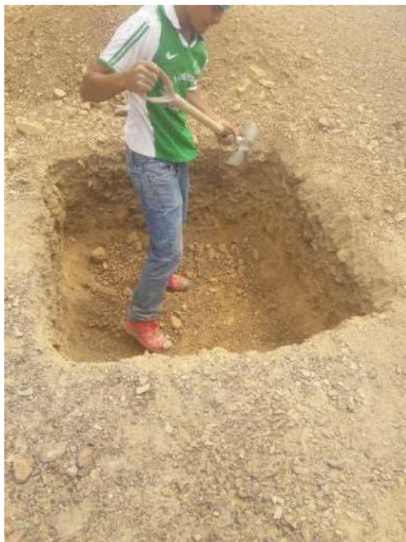
FIGURA 07: Excavación de calicatas
