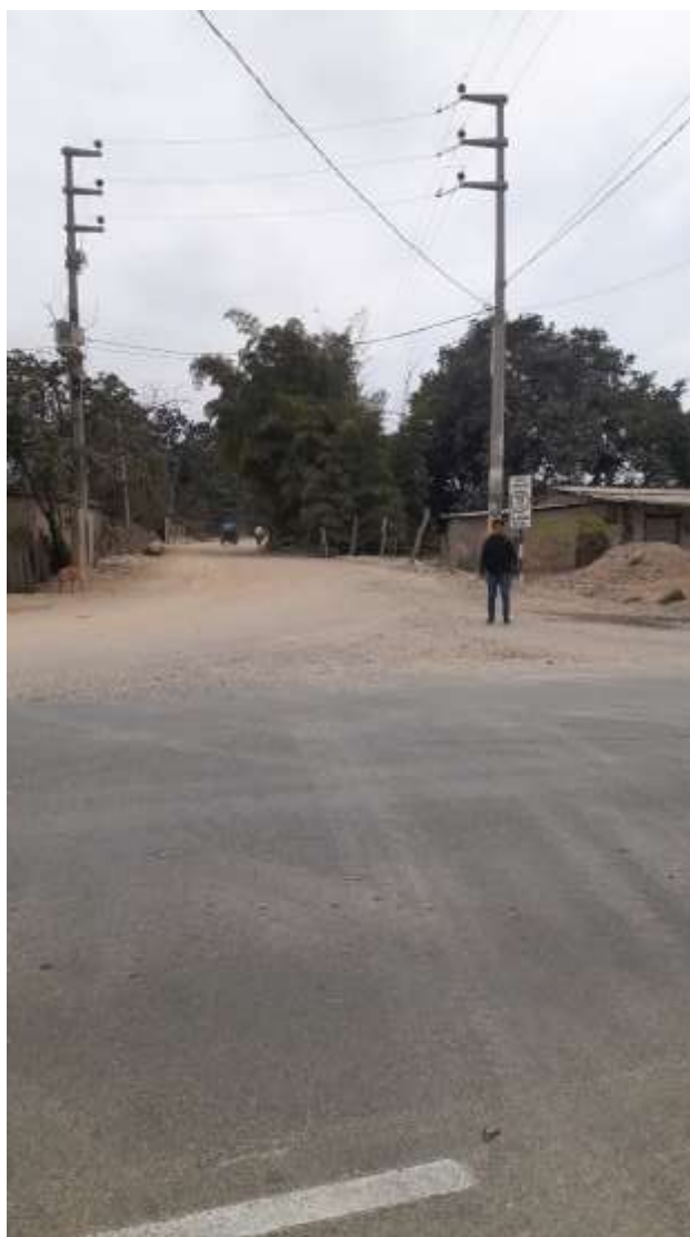
Fotografía N° 23: Servicio de Electricidad.
