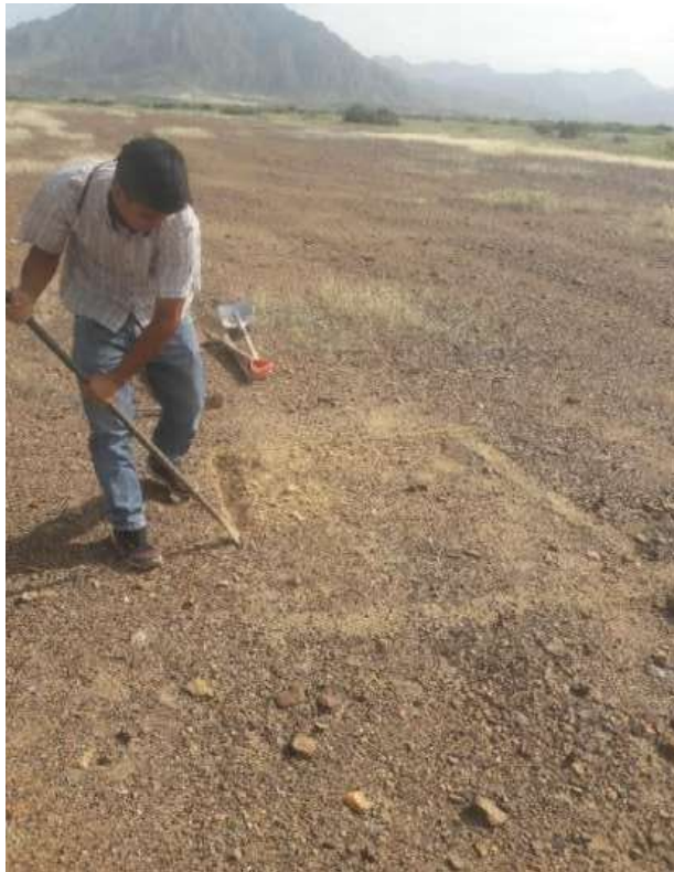
FIGURA 06: Delimitación de la calicata a excavar
