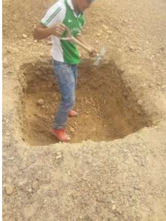
Fotografía N°1: Excavación de calicatas
