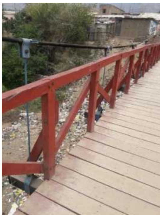
Fotografía N° 04: Basura en el puente colgante de Pátapo.
