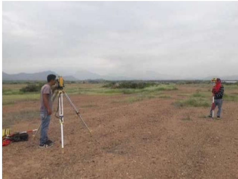
FOTOGRAFÍA N°2: Toma de puntos altos
