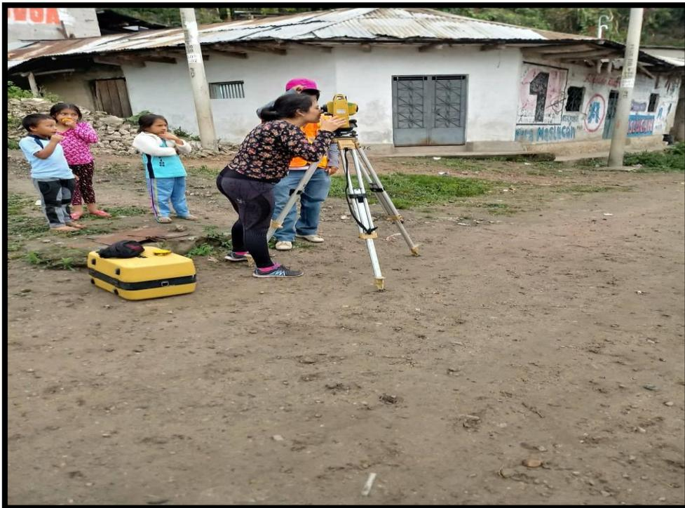
**Figura N° 14: Paso N°1: Levantamiento Topográfico en el tramo Santa Cruz – Nueva Santa Rosa.**
