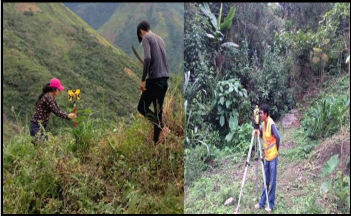
**Figura N° 20: Paso N°1: Levantamiento topográfico del tramo Nueva Santa Rosa- Los Libertadores, con presencia de neblina.**
