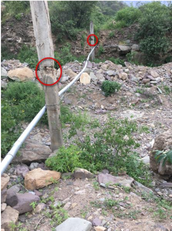
FOTOGRAFÍA N°13.10: Pase Aéreo en línea de conducción, columnas en mal estado.
