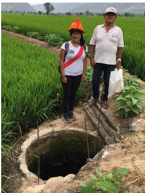
FOTOGRAFÍA N°13.7: Captación 3 manantial de fondo ubicado entre los caseríos Mochumi Alto y Mochumi Bajo.
