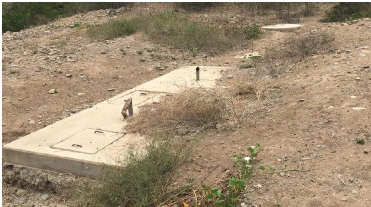
FOTOGRAFÍA N°13.23: Tanque Imhoff y lecho de secado.
