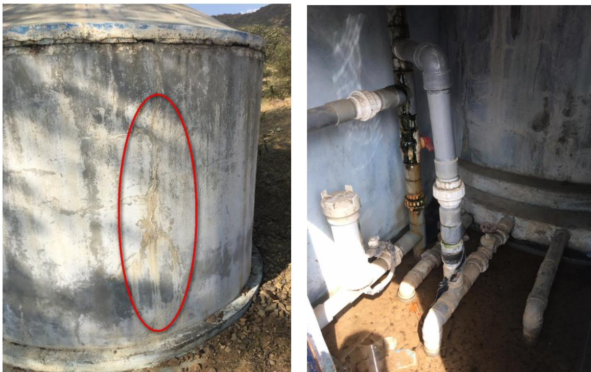
FOTOGRAFÍA N°13.16: Estado actual del reservorio de Traposa de 11 m3.
