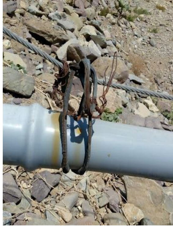
FOTOGRAFÍA N°13.10: Pase Aéreo en línea de conducción, columnas en mal estado.
