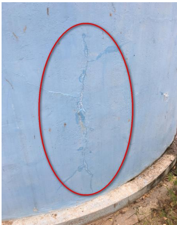
FOTOGRAFÍA N°13.15: Estado actual del reservorio de Mayascon de 16 m3.
