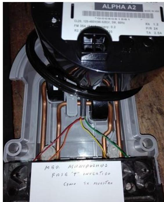
**Figura 58. Tipos de fraudes detectados en medidores electrónicos y electromecánicos.**
