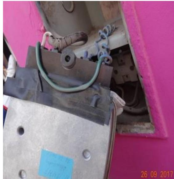
**Bornera puentada atrás de medidor**
