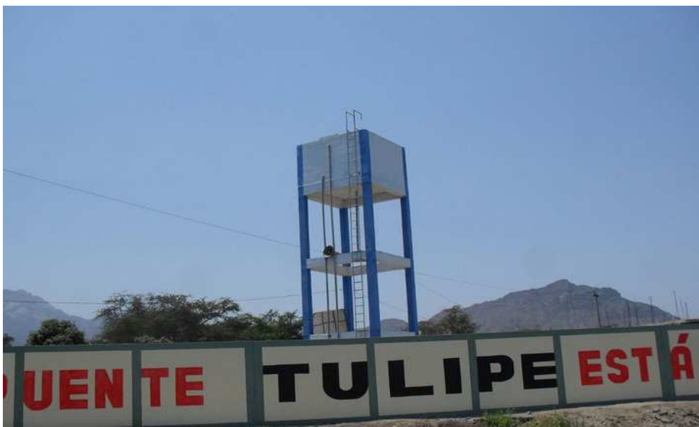
Tanque elevado del caserío puente Tulipe, que contiene agua extraída de subsuelo.
