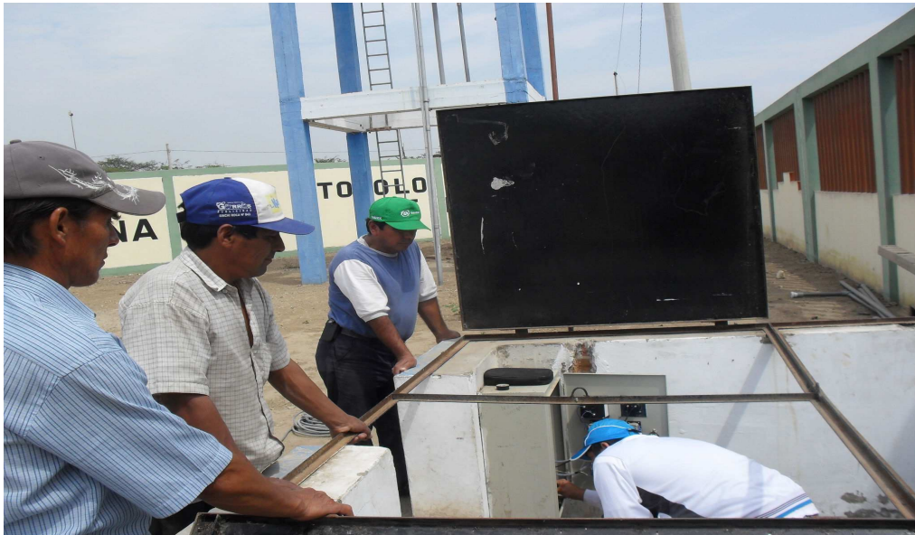
Pobladores apoyando en el mantenimiento del sistema de abastecimiento de agua en el Caserío.
