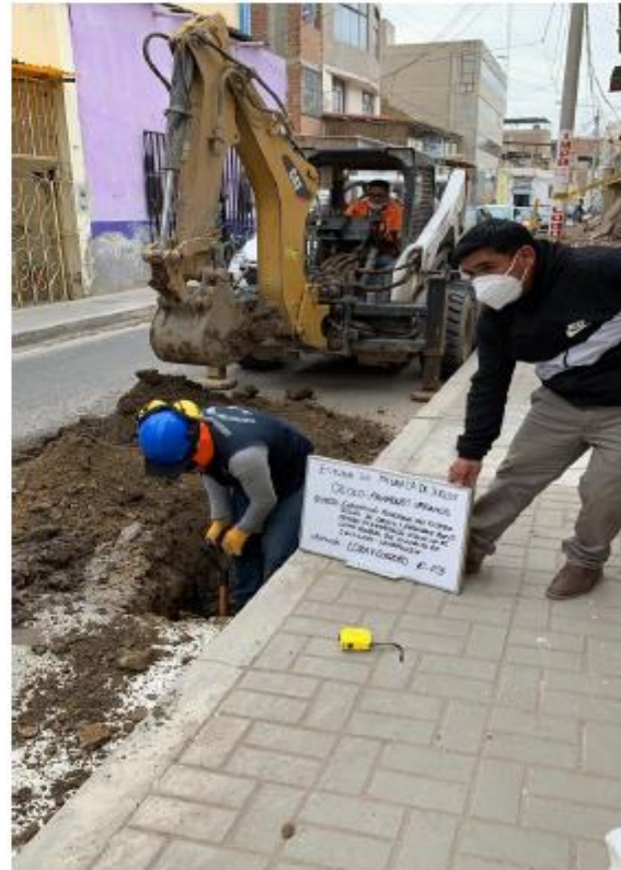
Imagen 9: Imágenes de la auscultación de pavimento en Lora y Cordero
