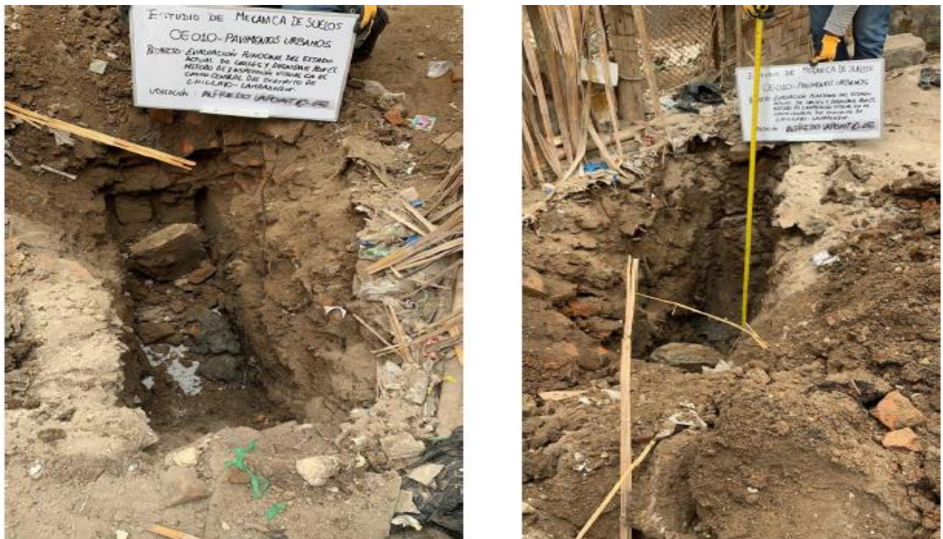
Imagen 8: Imágenes de la auscultación de pavimento en Alfredo Lapoint
