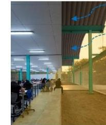
Renovación del aire a través de las bóvedas e iluminación por medio de su envolvente translúcido.
