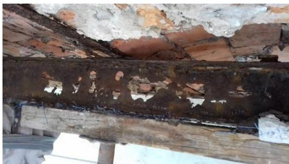
*Ilustración 5: Corrosión de acero. Año: 2021. Fuente: Isostatika.*
