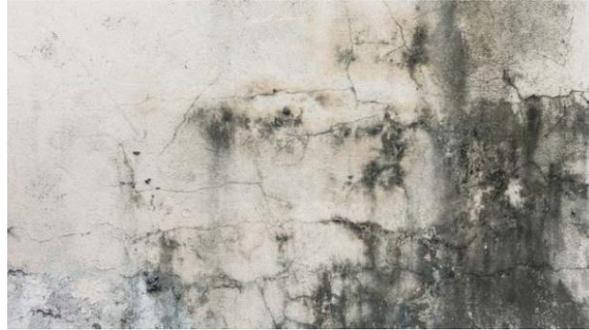
*Ilustración 3: Humedad por infiltración. Fuente: Hidrotec.*
