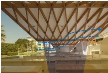
El mercado se iluminada gracias a que esta totalmente abierto al exterior y su cubierta permite una ventilación cruzada.
