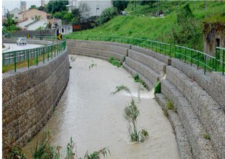
Fig. 7. MURO DE GAVIONES EMPLEADO EN EL ENCAUZAMIENTO DE UN RÍO
