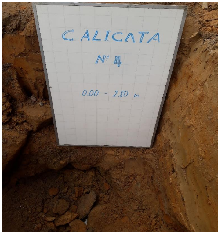
FOTOGRAFÍA N° 03 Vista de la calicata C-4
