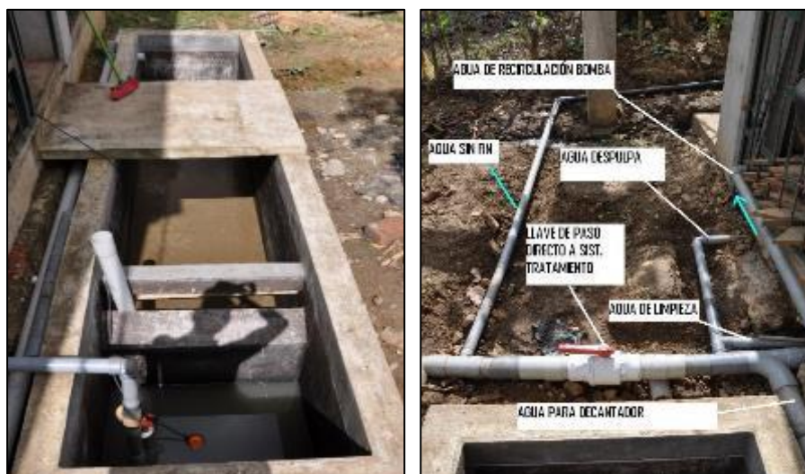
Figura 24. Sistema de recuperación de aguas residuales
