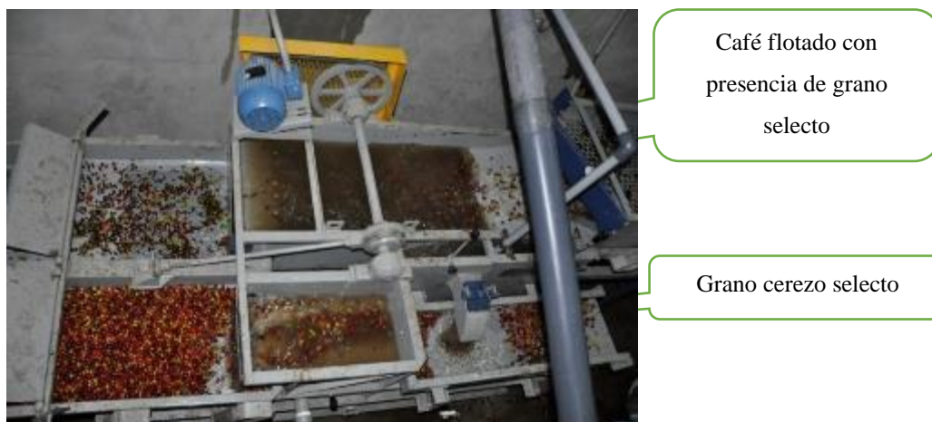
Figura 25. Sifón mecánico granos selecto y rebalse
