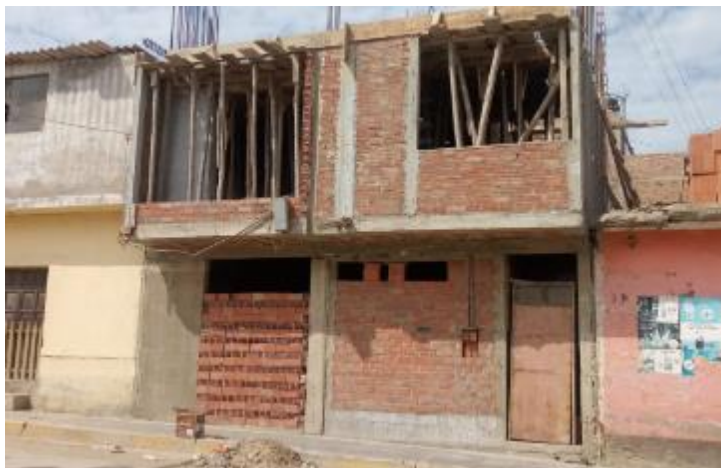
Figura 18. Generación de Residuos de Construcción
