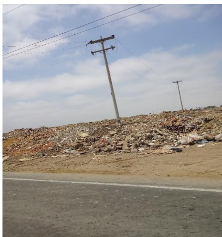
Figura 21. Disposición Final inadecuada de RCD
