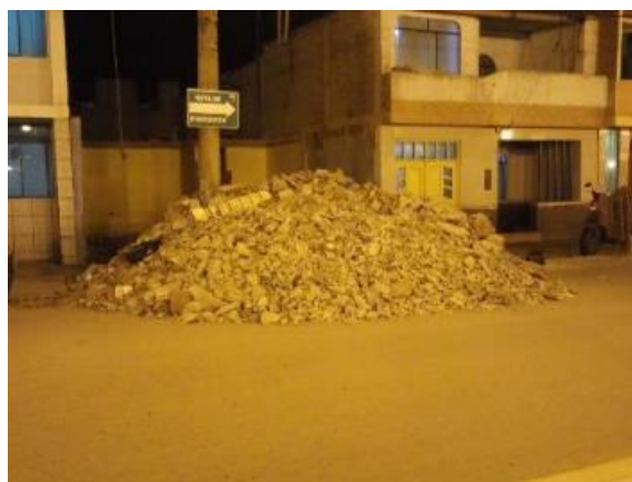
Figura 19. Generación de Residuos de Demolición
