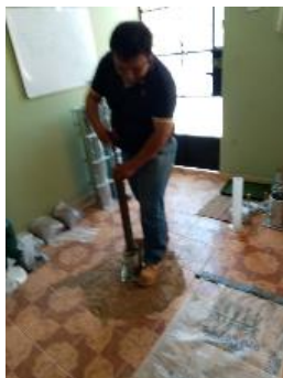
Imagen N° 47: Compactación de los especímenes
