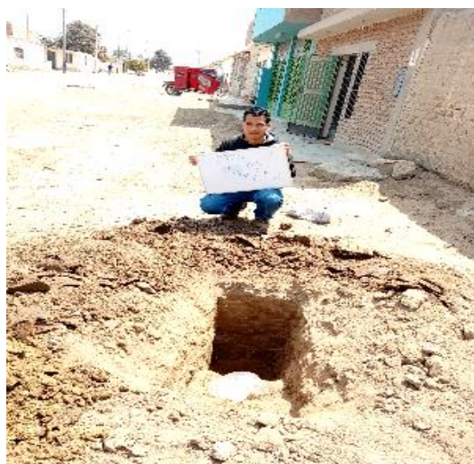
Imagen N° 17: Exploración de la calicata
