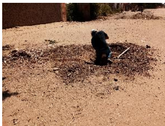
Imagen N° 16: Excavación de Calicata
