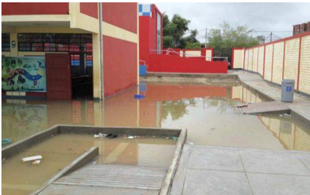
FOTOGRAFÍA N° 3.22: Colegio Federico Villareal inundado, por la falta de evacuación de lluvias.
