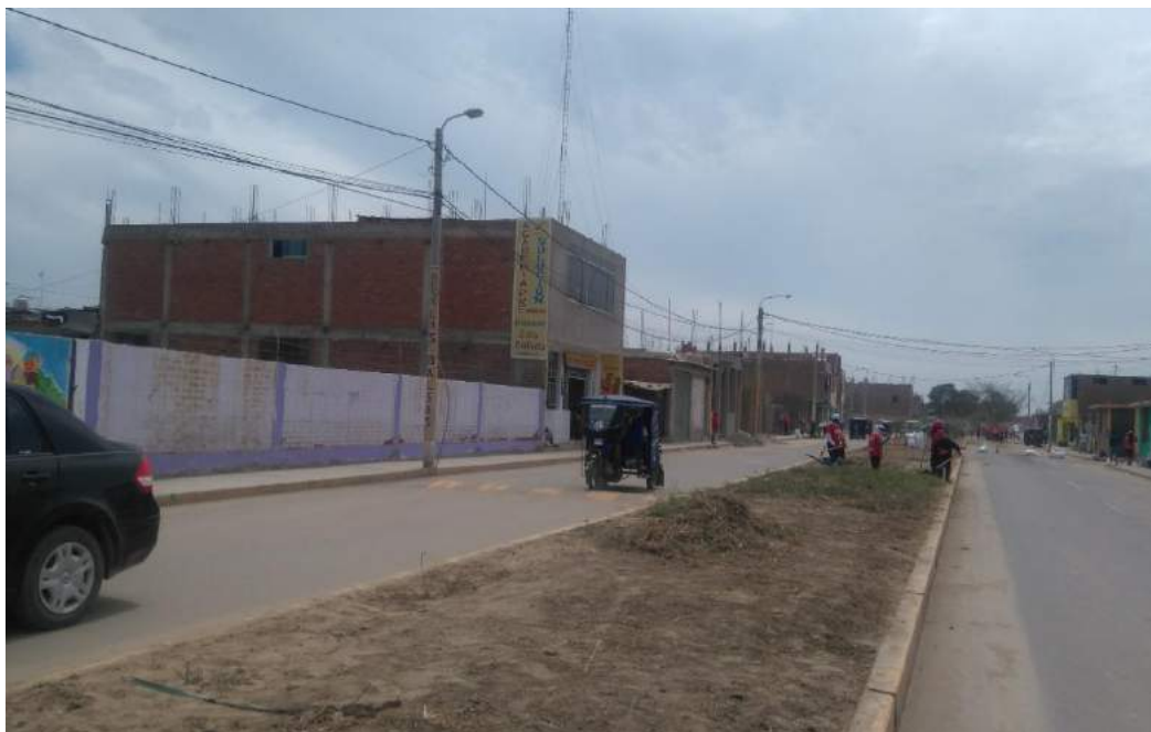
FOTOGRAFÍA N° 3.19: Ca. Unión; limpieza de Separador Central de las calles de Túcume, después de las lluvias.
