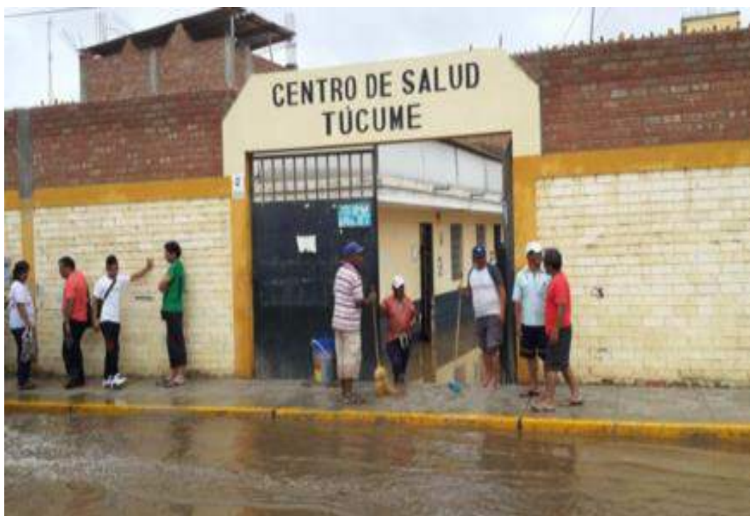
FOTOGRAFÍA N° 3.24: Centro de Salud de Túcume, inundado por las lluvias.
