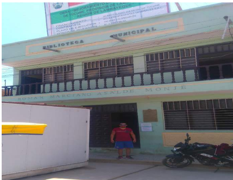
FOTOGRAFÍA N° 3.9: Biblioteca Distrital de Túcume (Área de DIDUR).
