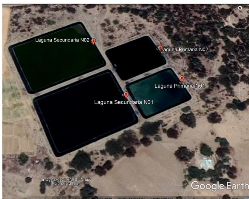
Figura 10. Tratamiento Secundario: Lagunas facultativas, dos primarias y dos secundarias
