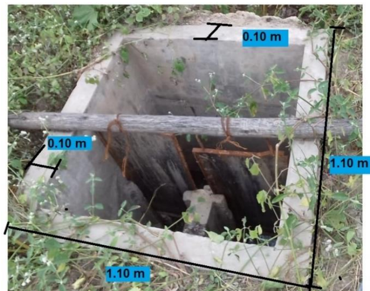
Figura 9. Tratamiento Preliminar: Repartidor de caudal
