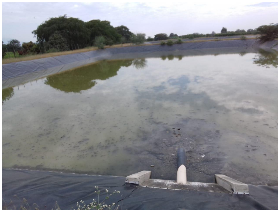
Figura 12. Laguna Primaria N01 con presencia de lodos y natas
