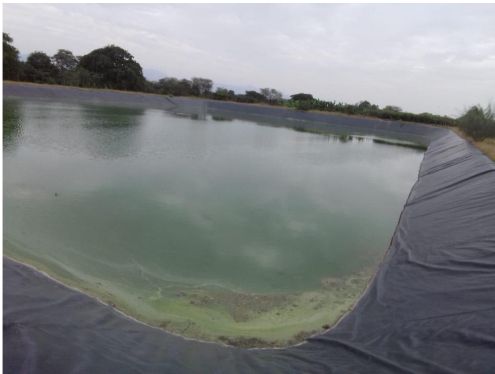
Figura 14. Laguna Secundaria N01 con zonas muertas en las esquinas
