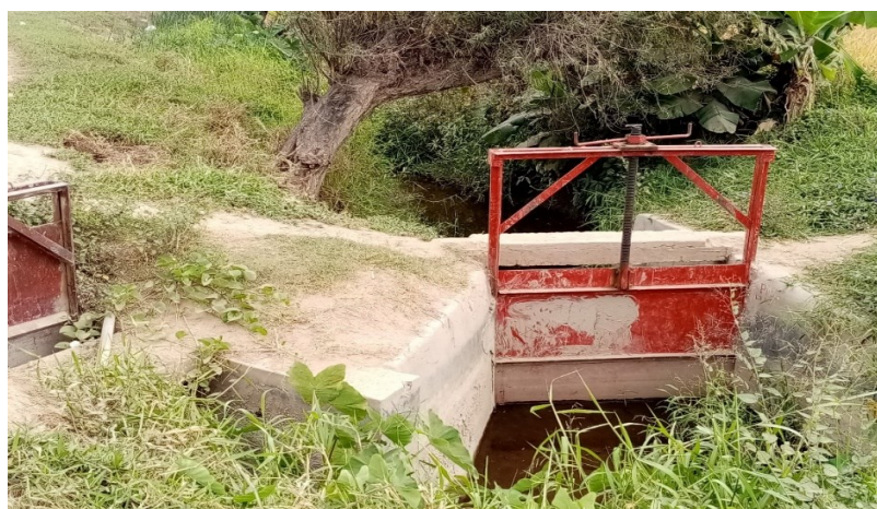
Imagen 1: Obras de obra existentes
