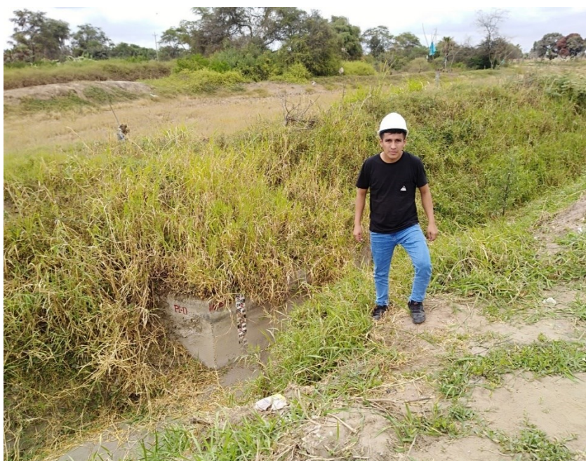
Imagen 5: Km 0.17 Final del canal revestido con concreto e inicio del canal sin revestir
