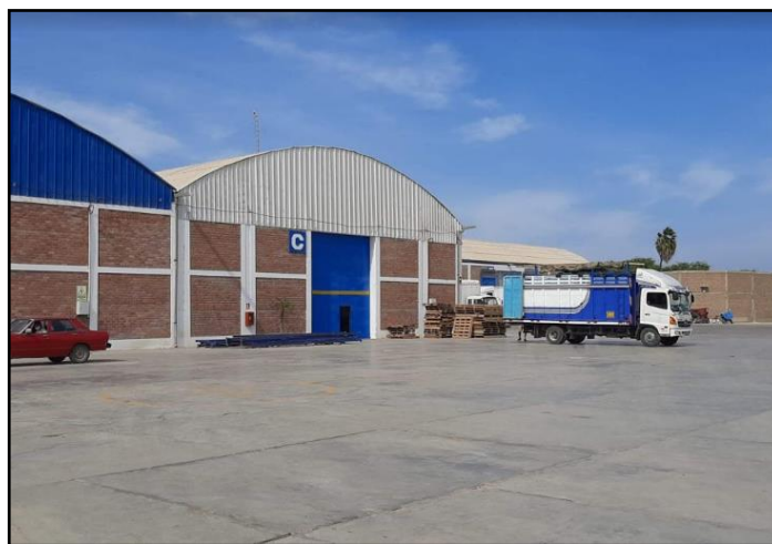
Ilustración 10 Nave de almacenamiento sucursal Norte
