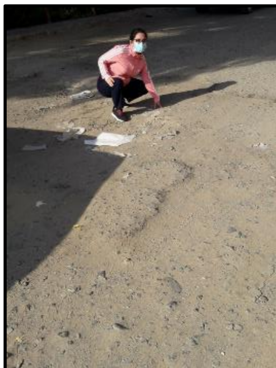
Fotografía 3.6 Estado actual de la calle Wilder Rodríguez Reyes
