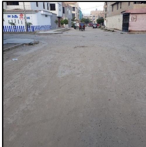
Fotografía 4. Huevo de severidad alta
