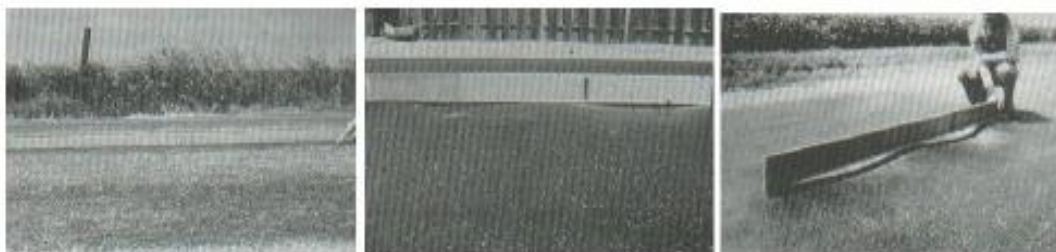
Figura 13. De izquierda a derecha, falla por corrugación de baja, media y alta severidad
