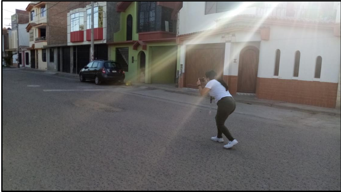
Fotografía 3.9 Falla de hueco, calle Carlos Uceda
