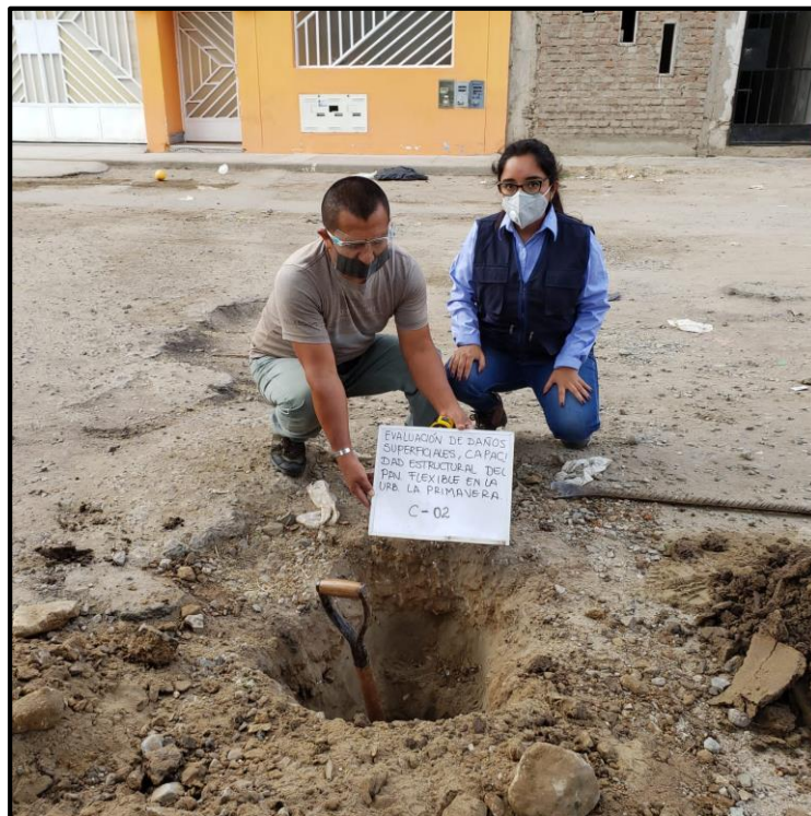
Fotografía 3.14 Calicata 2, Calle B Vásquez – W. Rodríguez
