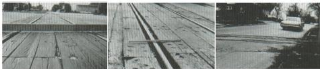
Figura 10. De izquierda a derecha, falla de cruce de vías férreas de baja, media y alta severidad
