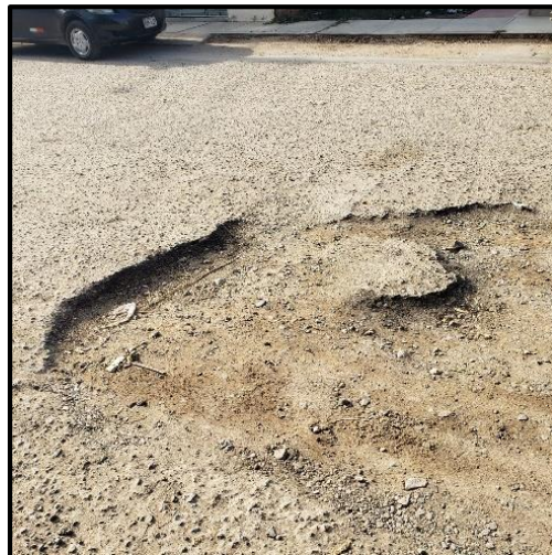
Fotografía 4. Huevo de severidad alta
