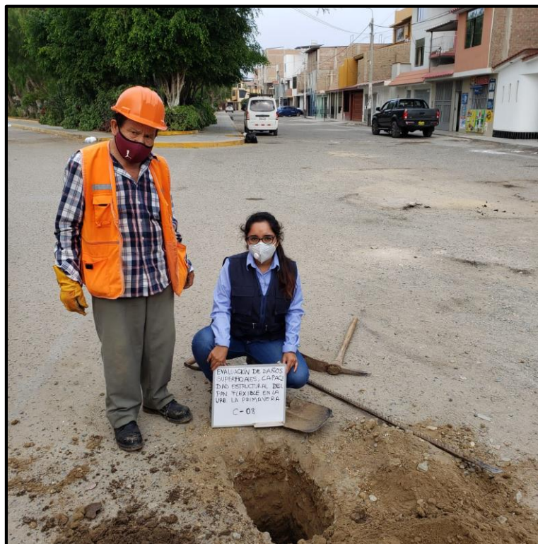
Fotografía 3.20 Calicata 8, Calle Castañeda y C. Horna
