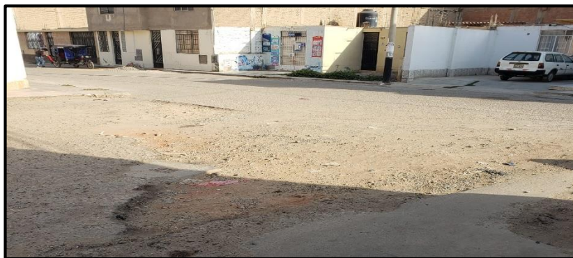
Fotografía 10. Huecos de severidad alta
