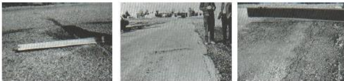
Figura 12. De izquierda a derecha, falla por abultamiento y hundimiento de baja, media y alta severidad
