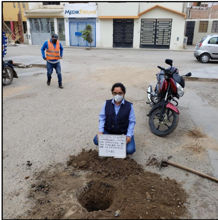
Fotografía 3.17 Calicata 5, Calle Ulises Ulloa y W. Valdiviezo
