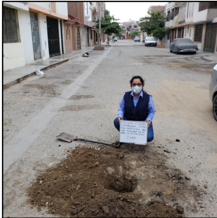
Fotografía 3.19 Calicata 7, Calle Víctor Fonseca y W. Valdiviezo
