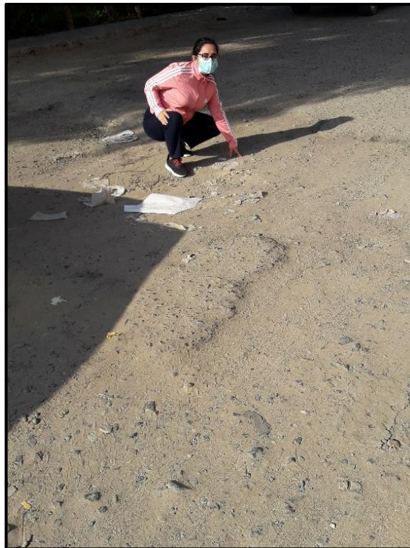
Fotografía 25. Desprendimiento de agregado de severidad alta
