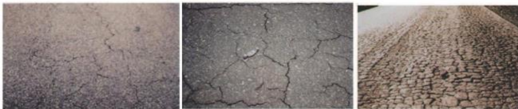
Figura 5. De izquierda a derecha, falla de piel de cocodrilo de baja, media y alta severidad
