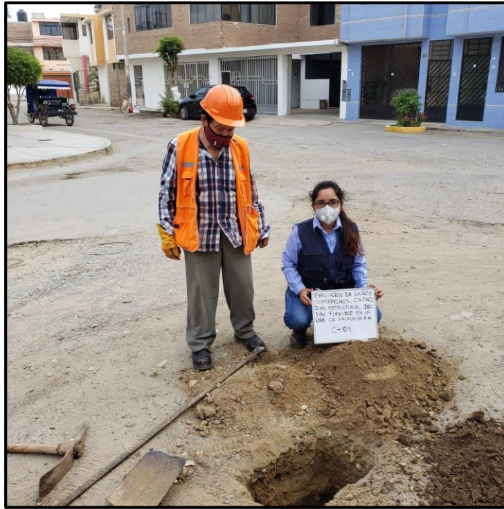
Fotografía 3.21 Calicata 9, Calle Juan Ramos y E. Coral
