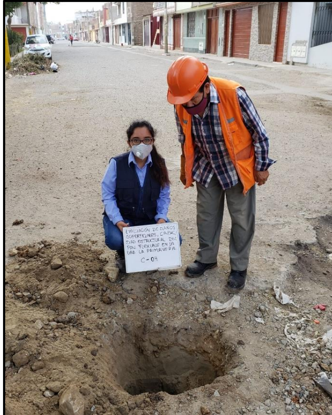
Fotografía 3.16 Calicata 4, Calle Eleodoro Coral y Carlos Uceda
