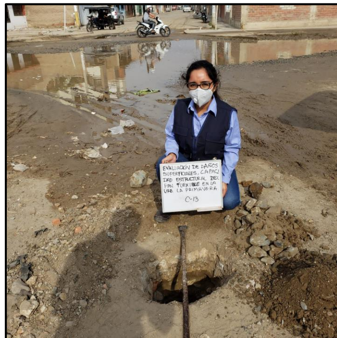
Fotografía 3.24 Calicata 13, Calle Ángel G. Cornejo y E. Lora y Lora
