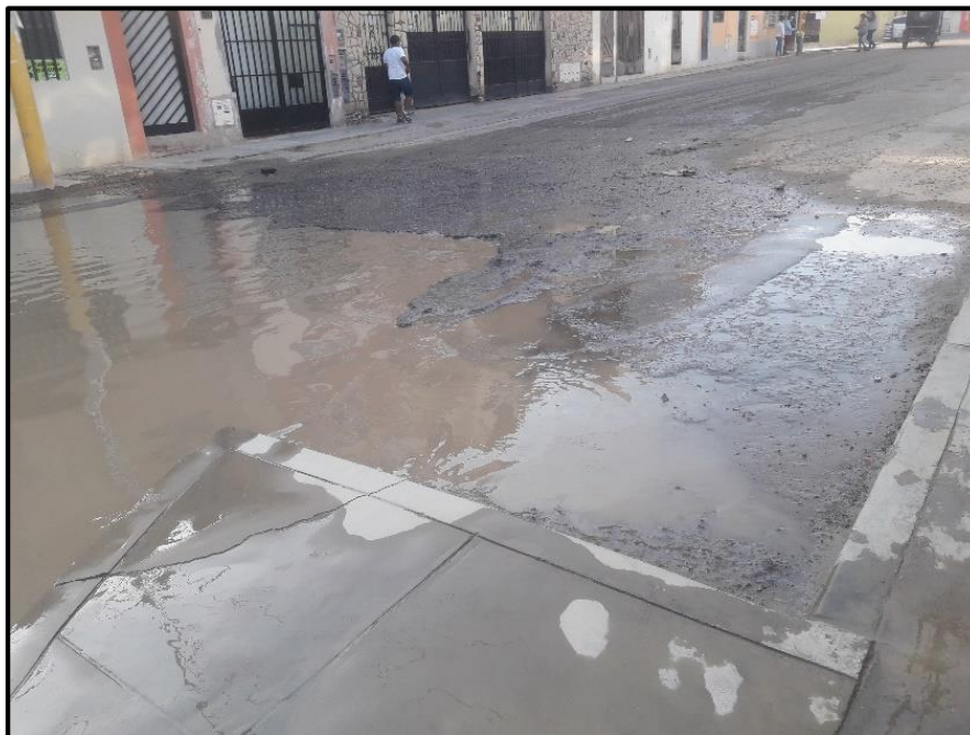
Fotografía 17. Huevo de severidad alta
