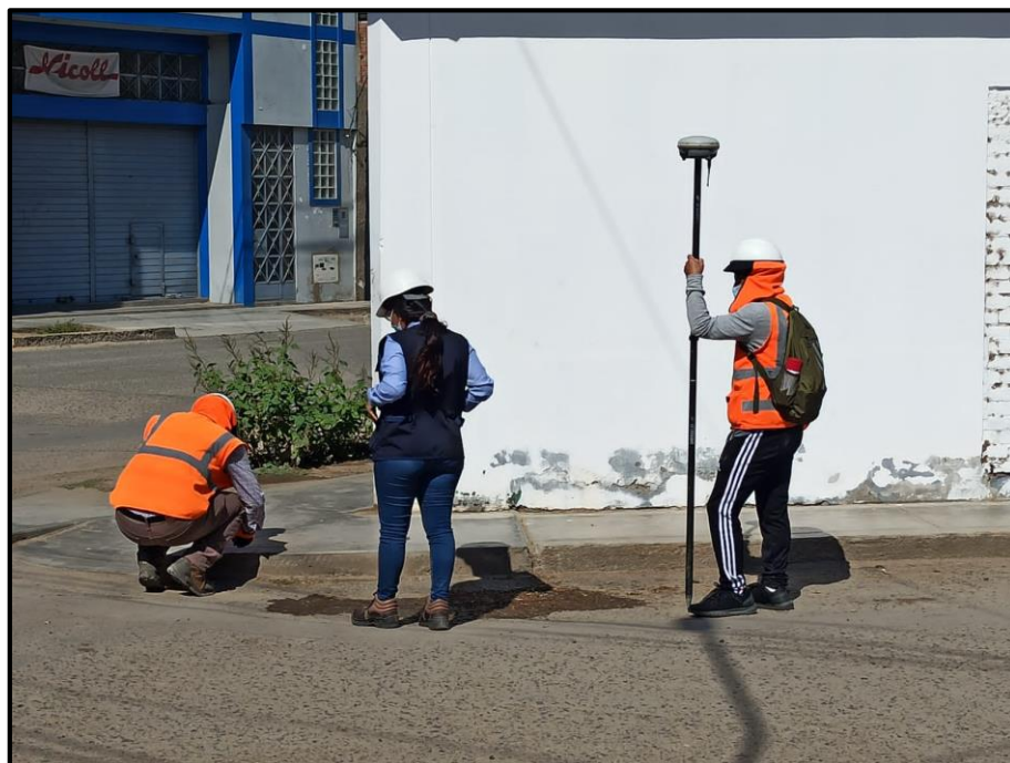
Fotografía 3.32 Colocación del BM
