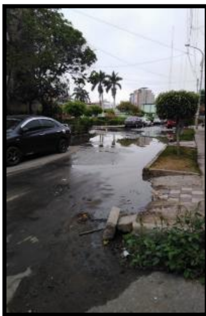
Figura 52- Calle Alcalá después de una lluvia en el mes de febrero- 2021
