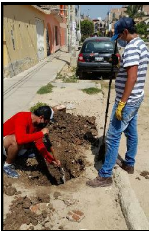
Fotografía N°15- Excavación de la Calicata N°02
