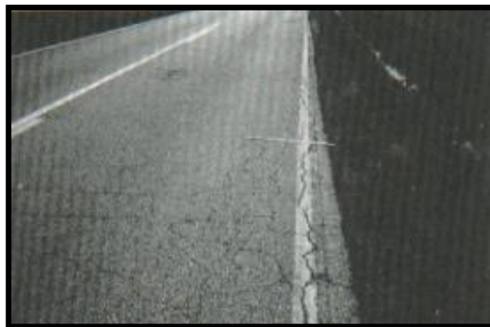
Figura 11- Falla Piel de Cocodrilo- Severidad media
