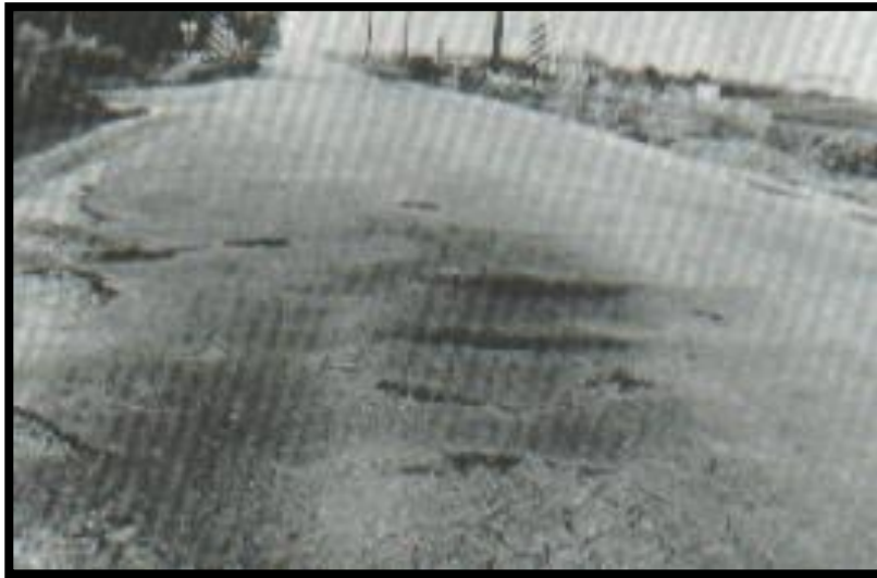
Figura 26- Falla Desplazamiento- Severidad media
