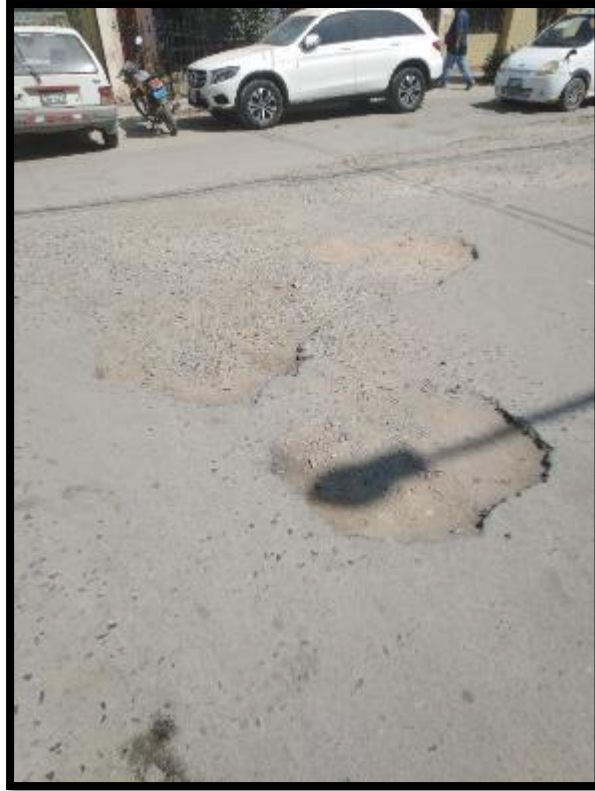
Fotografía 41- Falla de Meteorización en la intersección de la calle Alcalá con Cádiz
