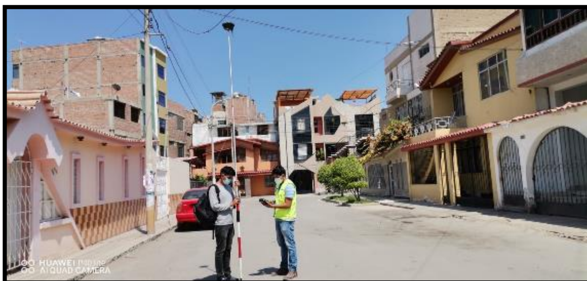
Fotografía 06- Toma de punto en calzada con el GPS receptor dinámico
