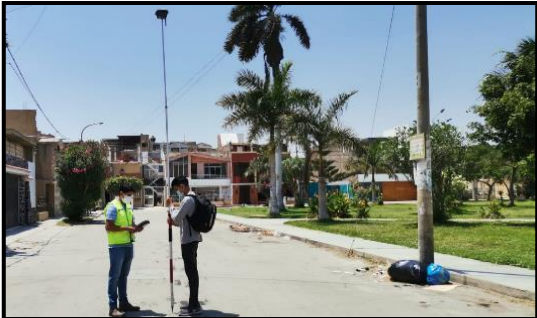
Fotografía 04- Toma de punto en el centro de la calzada con el GPS receptor dinámico
