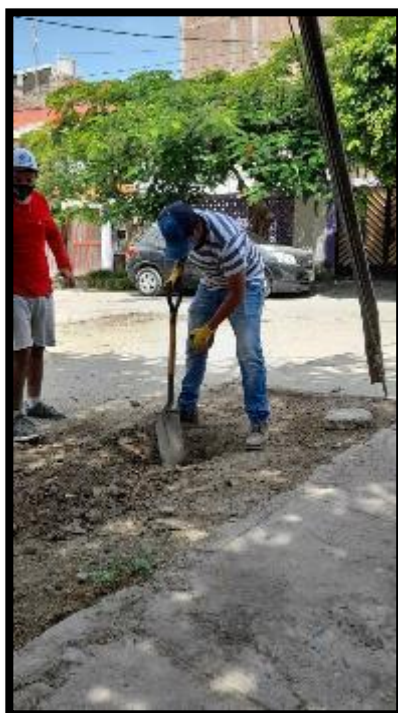
Fotografía 17- Excavación de la Calicata N°03
