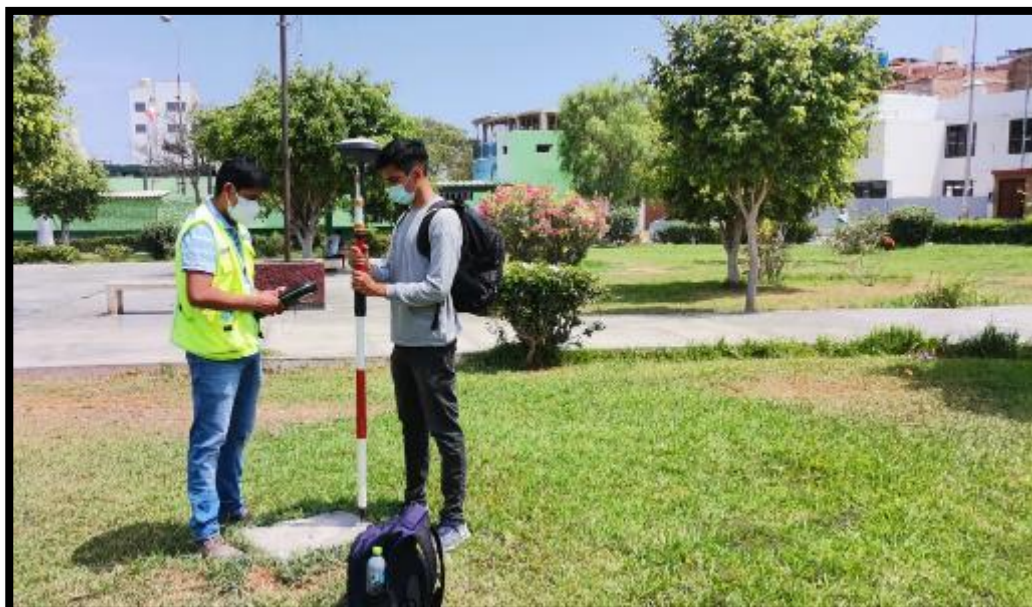
Fotografía 10- Toma de punto del BM 04 con el GPS receptor dinámico
