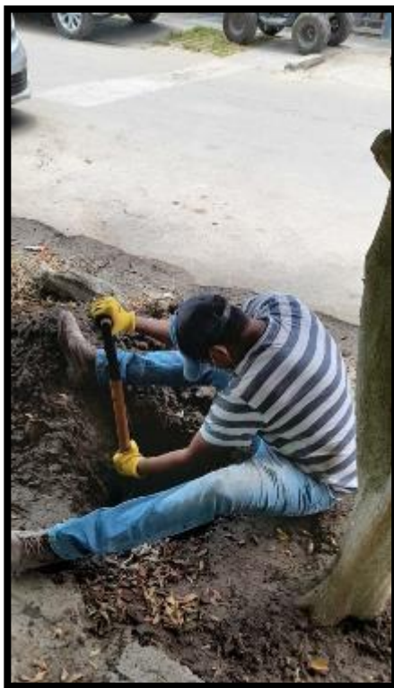
Fotografía 20- Excavación de la Calicata N°04
