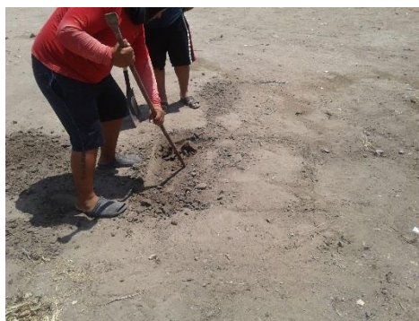
Figura 33: Excavación de calicatas
