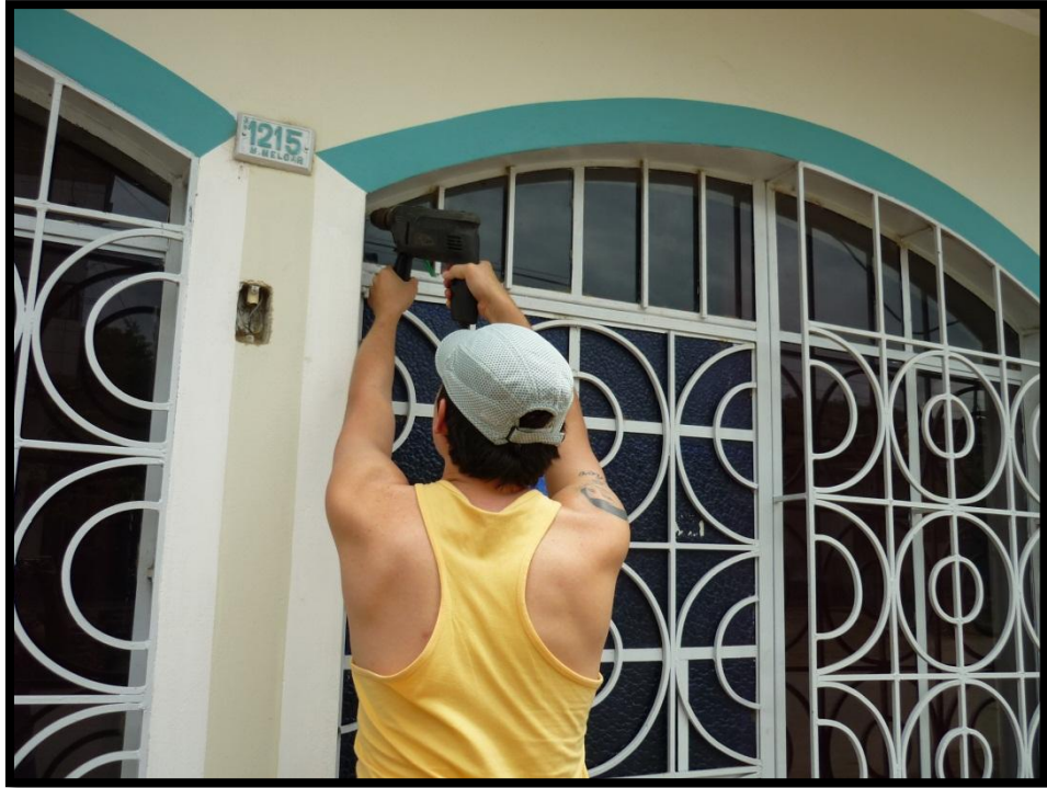
Taladrado de la pared para poder pasar el cable USB de las cámaras
