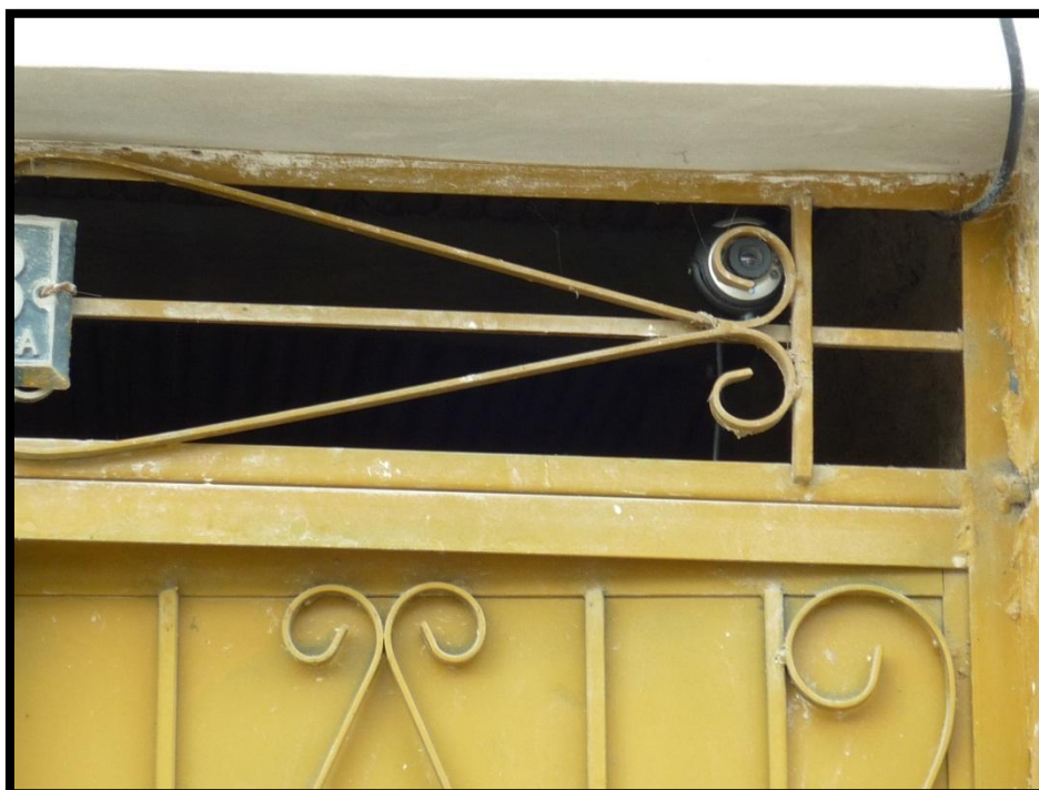
Posicionamiento de la cámara antes de colocar la protección
