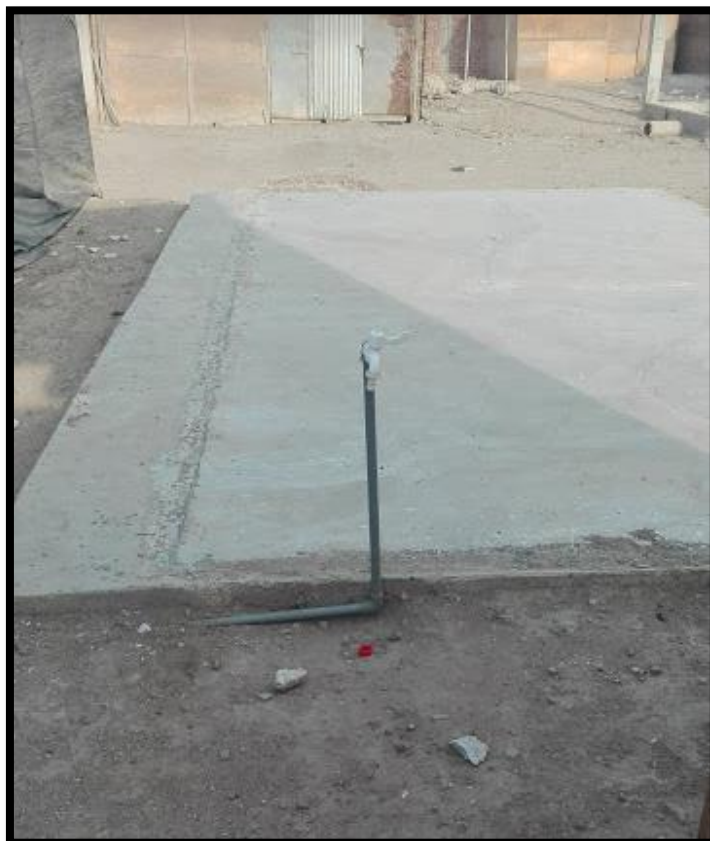
Fotografía 9.7. Conexiones de Agua Clandestinas.
