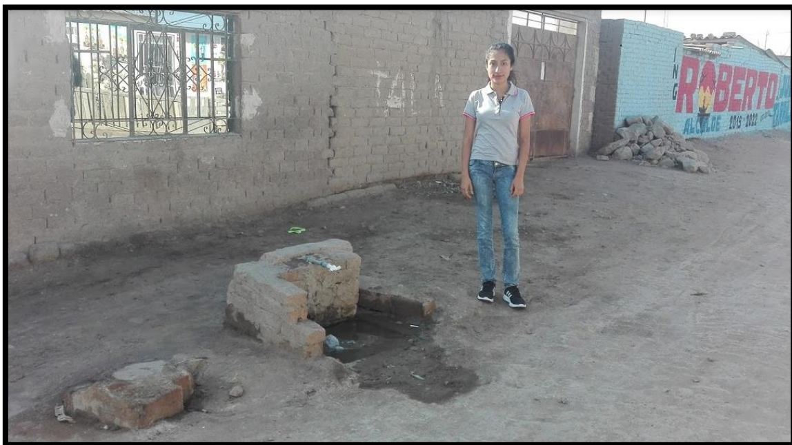
Fotografía 9.4. Pileta Para Abastecimiento de Agua.
