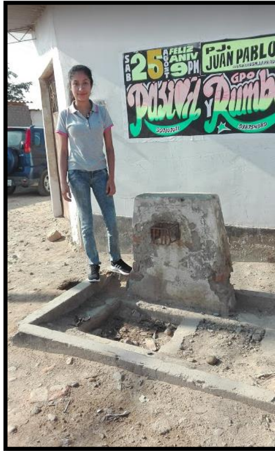
Fotografía 9.1. Pileta Para Abastecimiento de Agua.
