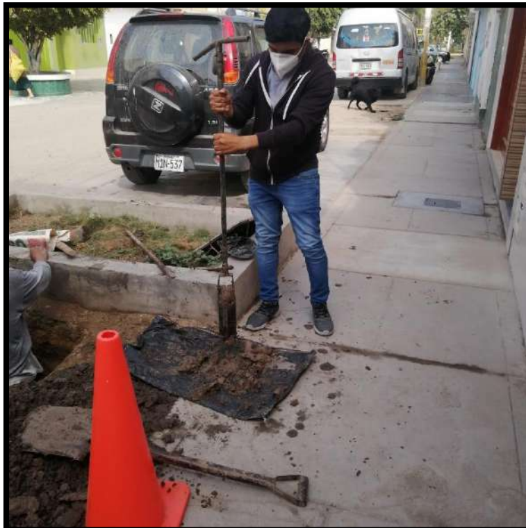
Fotografía 10 – Muestras extraídas para ensayo de corte directo de la calicata 02
