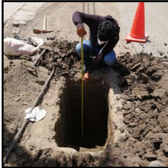
Fotografía 16 – Profundidad de excavación en calicata 04
