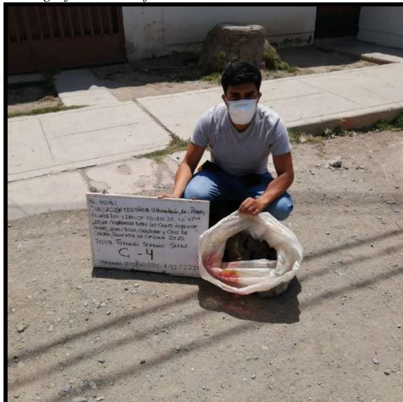
Fotografía 17 – Profundidad de excavación en calicata 04
