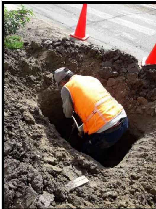
Fotografía 6 – Excavación de la calicata 01 en la calle Chongoyape
