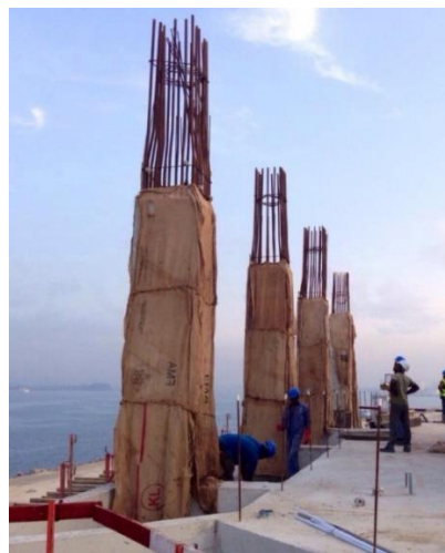
Imagen 06. Curado de columnas mediante lonas húmedas, amortigua la responsabilidad de riego periódico.
