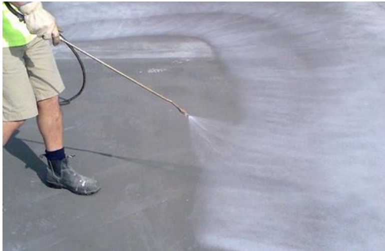
Imagen 8. Aplicación del aditivo curador por aspersión, uno de los rendimientos más comunes es de 1 litro cada 5m 2 .
