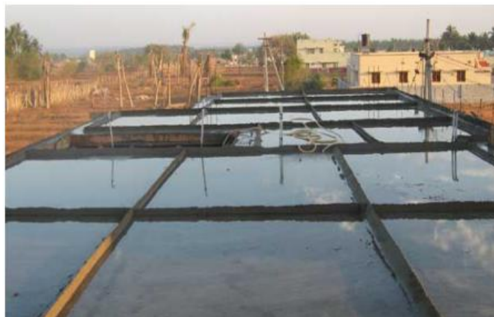
Imagen 9. Curado por inundación en una losa ayudado por diques de arena, método muy poco amigable con el medio ambiente.
