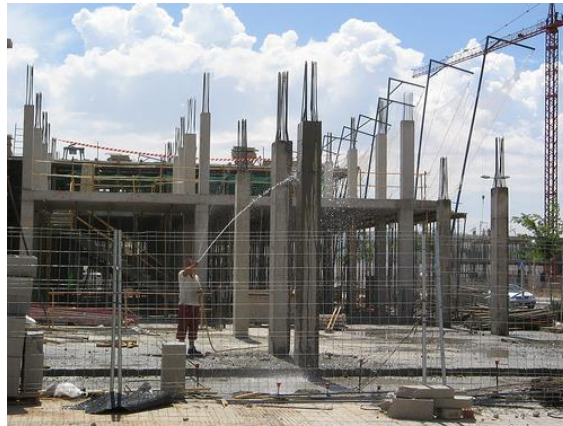
Imagen 05. Curado periódico mediante riego, se observa la dificultad de aplicación para elementos verticales.
