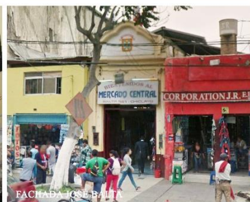
FACHADA JOSE BALLARIN
