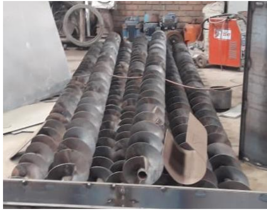
Fig. 13 Resultado del proceso de soldadura y emparejamiento
