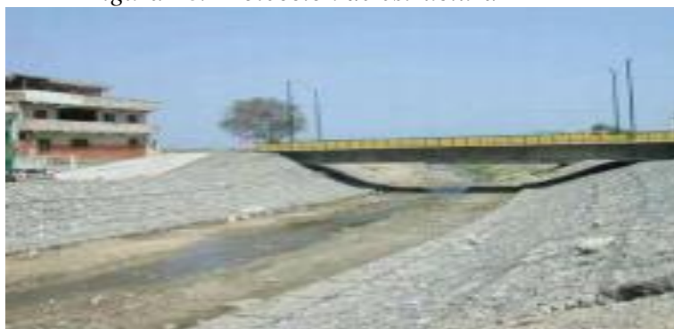
Figura 18. Protección de estructura
