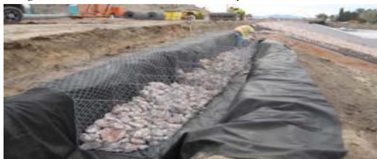
Figura 12. Elaboración de mallas y enrocado
