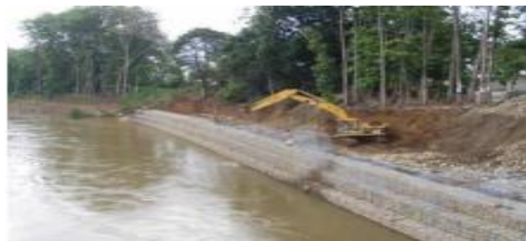
Figura 13. Colocación de mallas en banquetas
