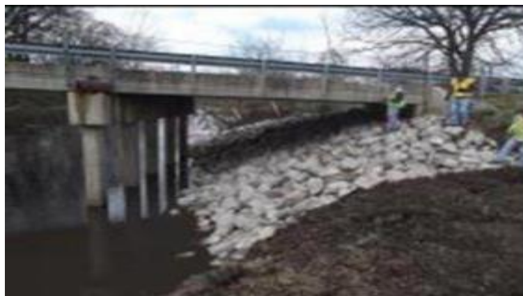
Figura 20. Protección de estribo
