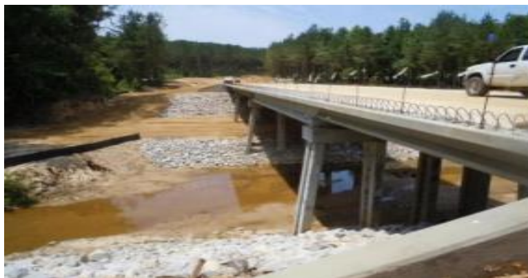
Figura 19. Protección de estructura
