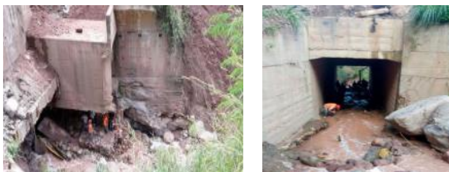
Figura 28. Recalce de cimentaciones
