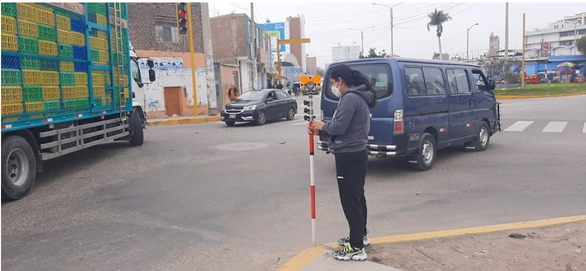
Ilustración 71: Realización del levantamiento topográfico.
