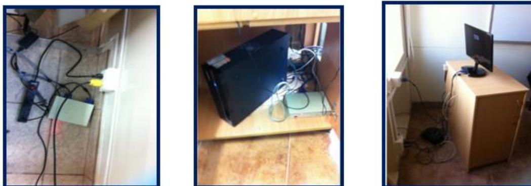
Figura N° 36: Distribución inadecuada de cableado de equipos multimedia en aulas.
