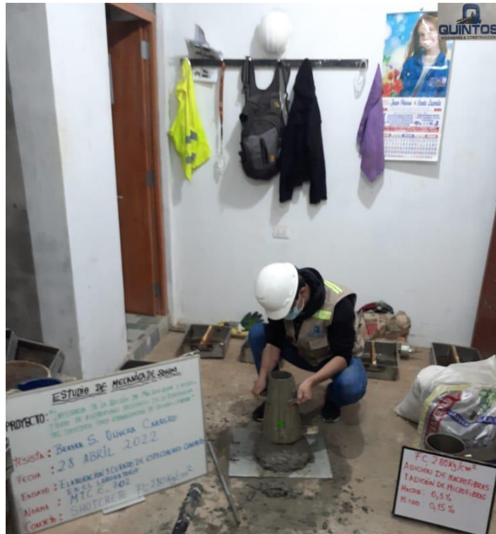
Anexo 90: Levantamiento de Cono de Abrams para medición de Slump en Concreto. Fuente: Propia
