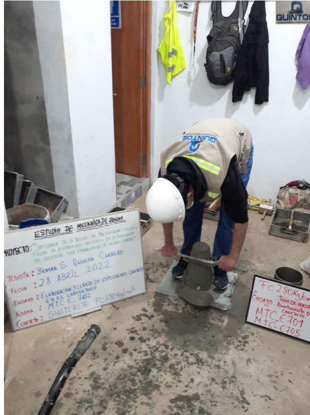
Anexo 73: Ensayo de Slump de Agregado en estado fresco. Fuente: Propia
