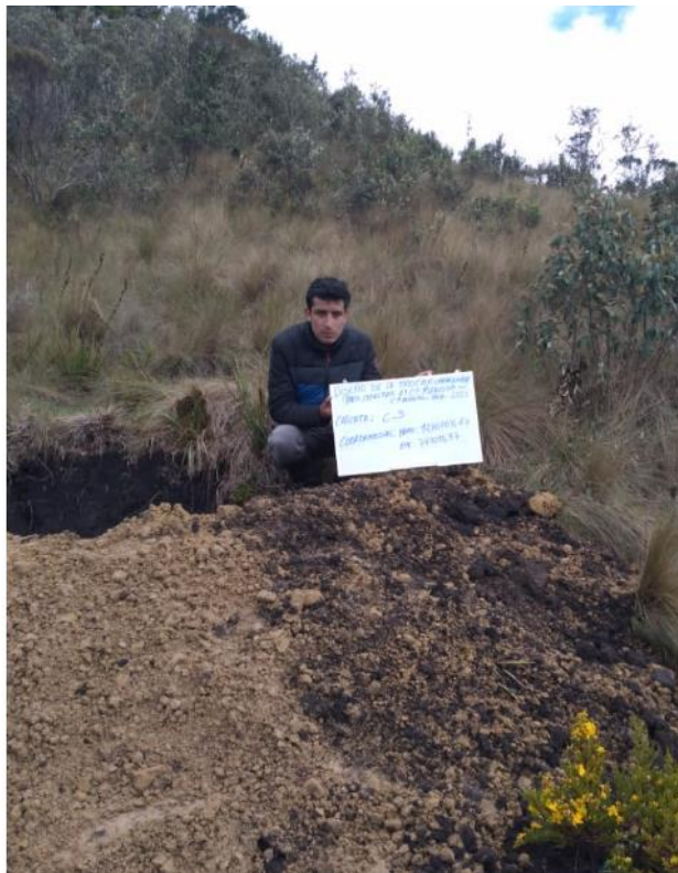
FOTOGRAFÍA N° 9. Vista general de la Calicata C-05.
