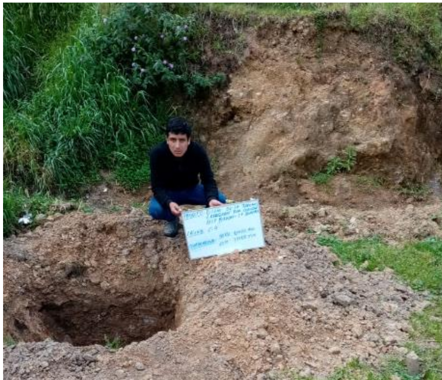
FOTOGRAFÍA N° 7. Vista general de la Calicata C-04.
