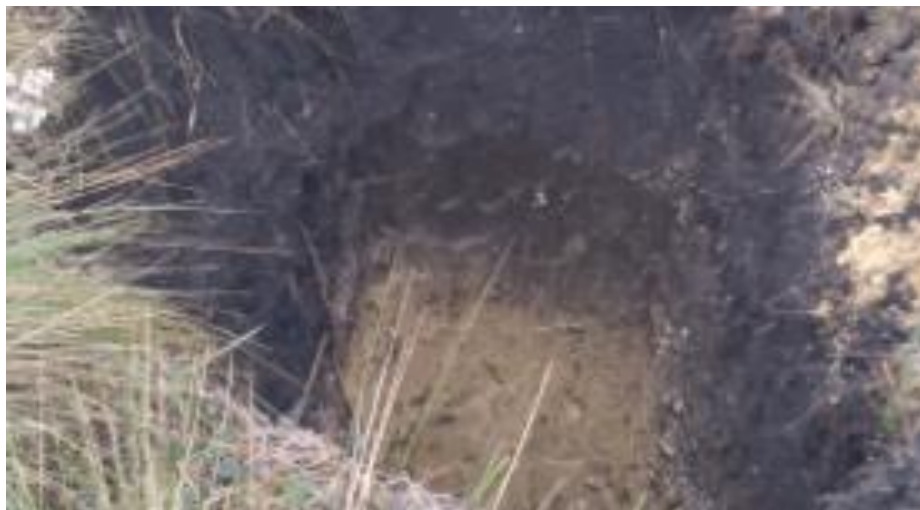
FOTOGRAFÍA N° 12. Vista de Perfil Estratigráfico de la Calicata C-06.
