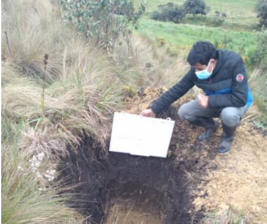
FOTOGRAFÍA N° 11. Vista general de la Calicata C-06.
