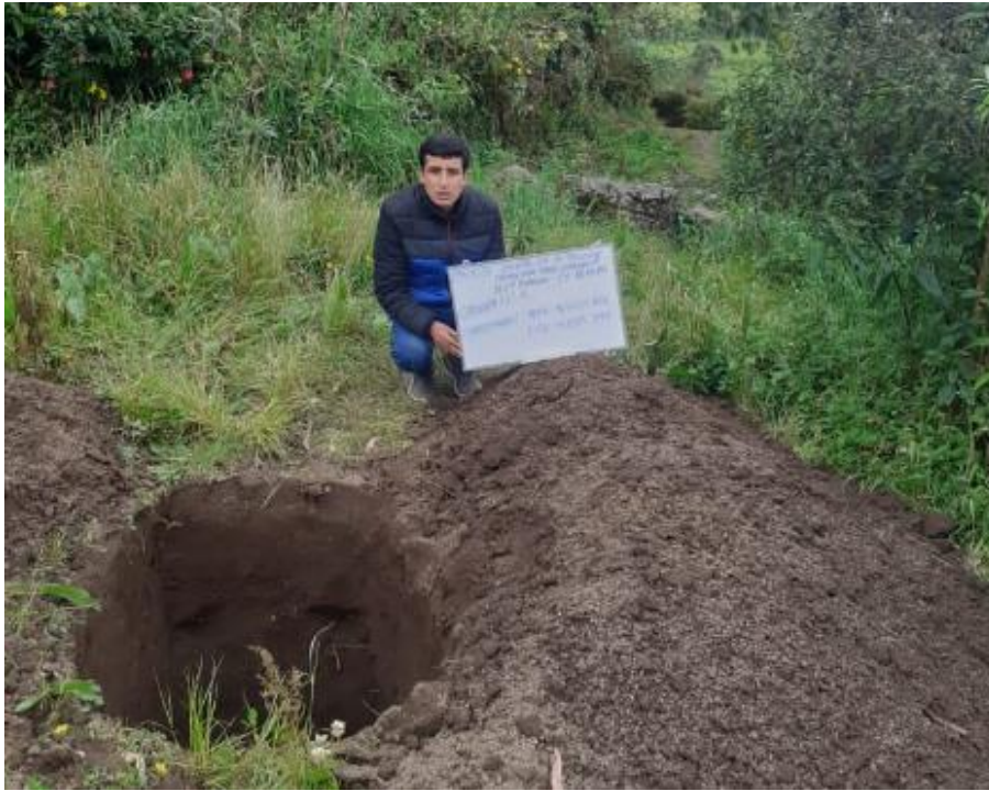
FOTOGRAFÍA N° 3. Vista general de la Calicata C-02.
