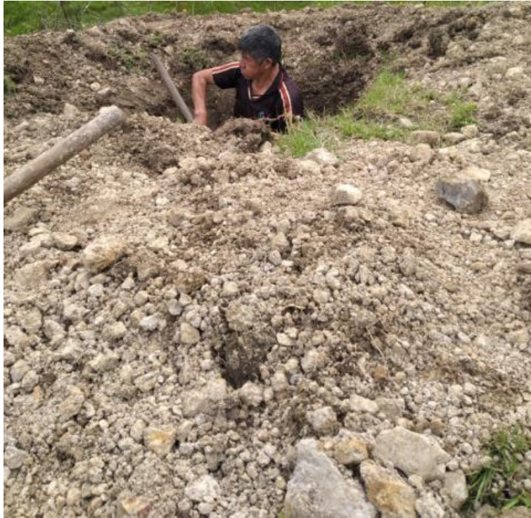
FOTOGRAFÍA N° 5. Vista general de la Calicata C-03.
