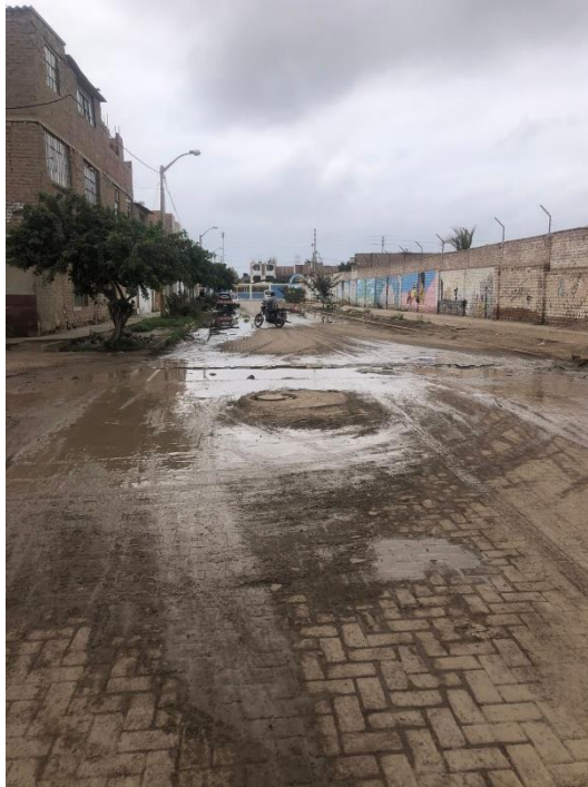
Fotografía 05. Buzones colapsados
