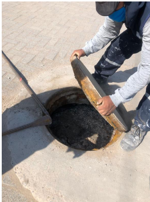
Fotografía 06. Buzón colapsado
